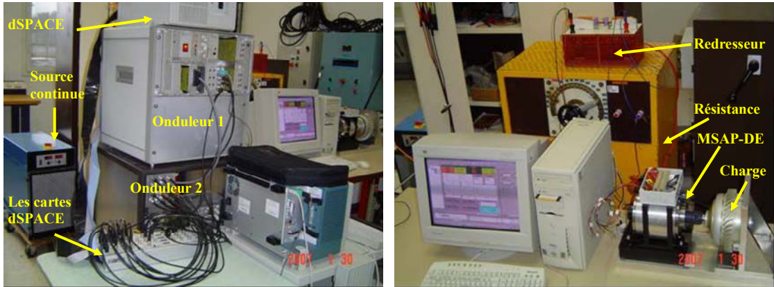
(a) : Schéma de montage expérimental, (b) : la partie de la MSAP et charge.
