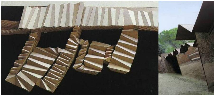
Figure 82. RCR, exemple du chai « Bell-Hoe winery » construit en Espagne utilisant à plusieurs reprises l'opération « plisser » pour la conception de la toiture.
