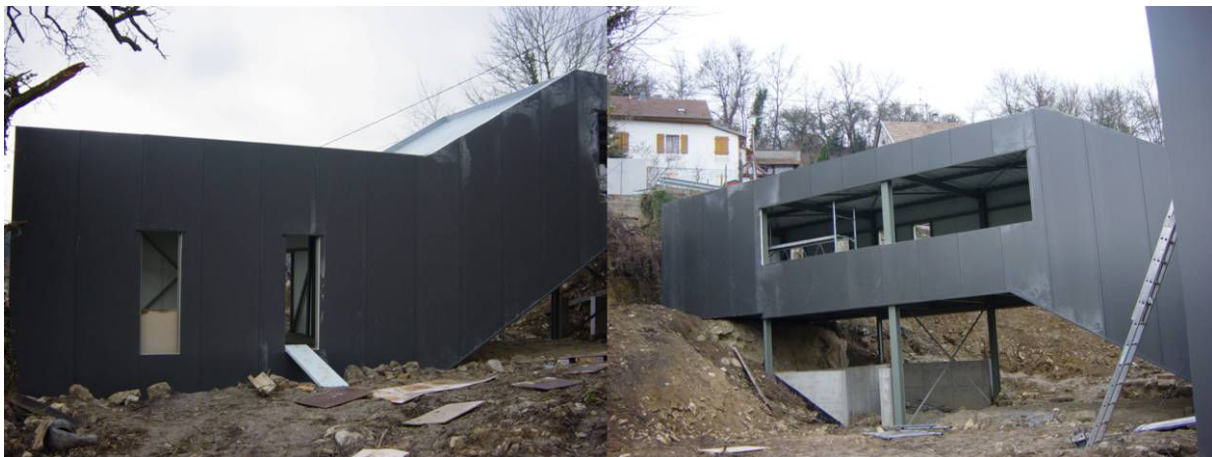
Figure 196. Maison Doll en cours de réalisation.
