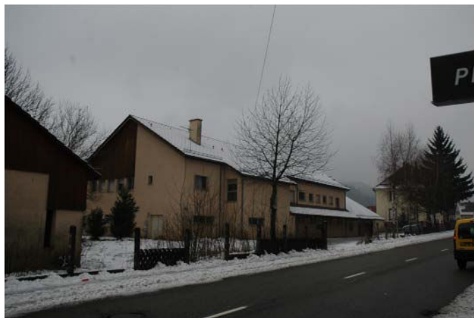
Figure 205. Photo du bâtiment existant.
