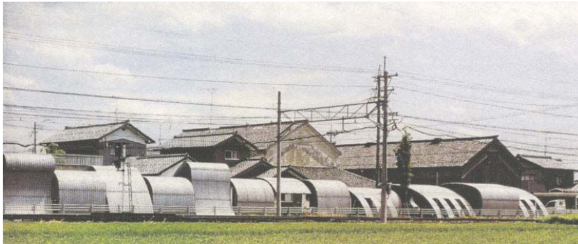
Figure 85. Gare ferroviaire et abri à bicyclettes, Fukui, Japon, Shuhei Endo Architect Institute.
