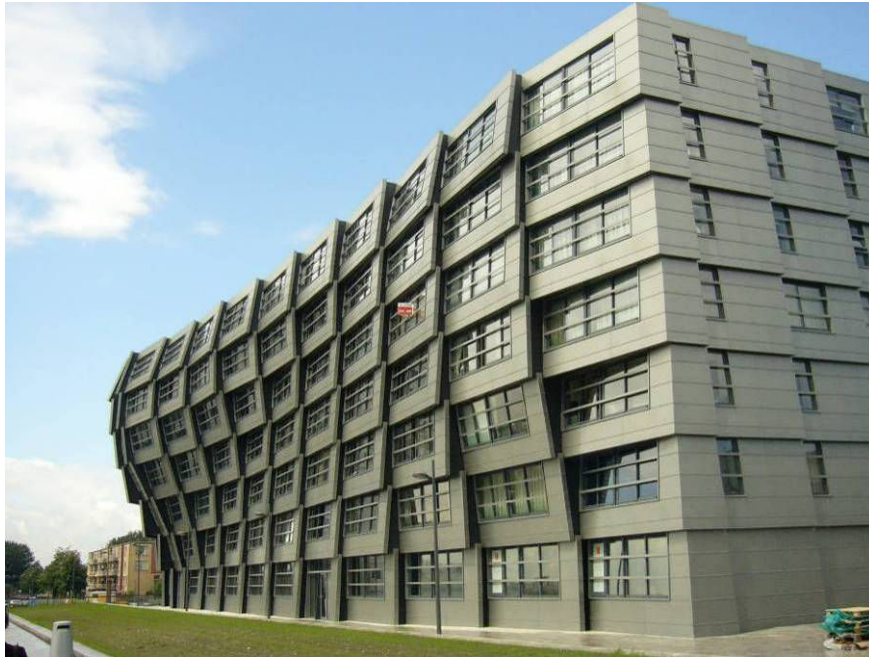
Figure 240. «the Wave» immeuble de logement construit à Almere (Pays-Bas) par l'architecte René Van Zuuk.
