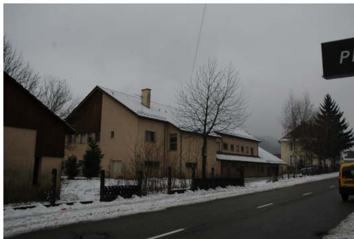
Figure 205. Photo du bâtiment existant.
