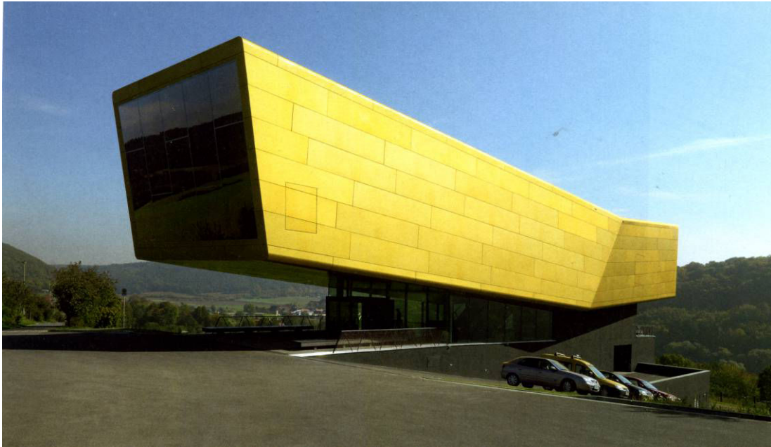
Figure 235. « Besucherzentrum » de l'architecte Holzer Kobler ("Swiss performance 08", 2008).
