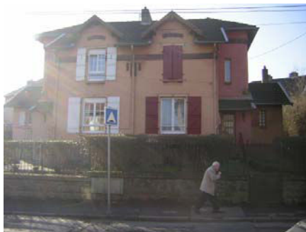
Bâtiment n°1036 (zone 6)
