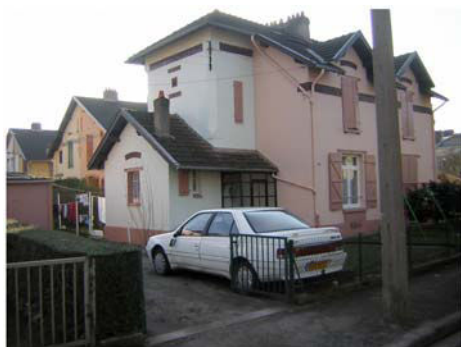
Bâtiment n°994 (parcelle 174/175)
