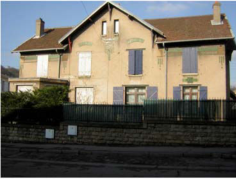
Bâtiment n°1004 (rue du Marechal Foch - Parcelle : 246/245)
