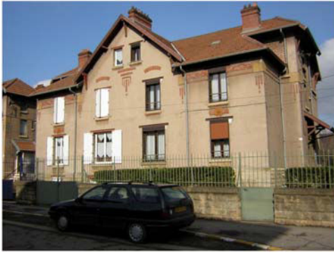
Bâtiment n°963(rue du Commerce - Parcelle : 216/217)
