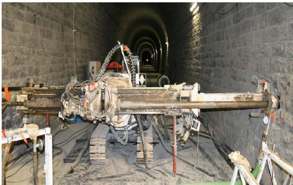
Figure 5 : Réalisation du « trou pilote dans la station expérimentale de Tournemire (pour le schéma du carottier, voir la Figure 95 de l'ANNEXE B)
