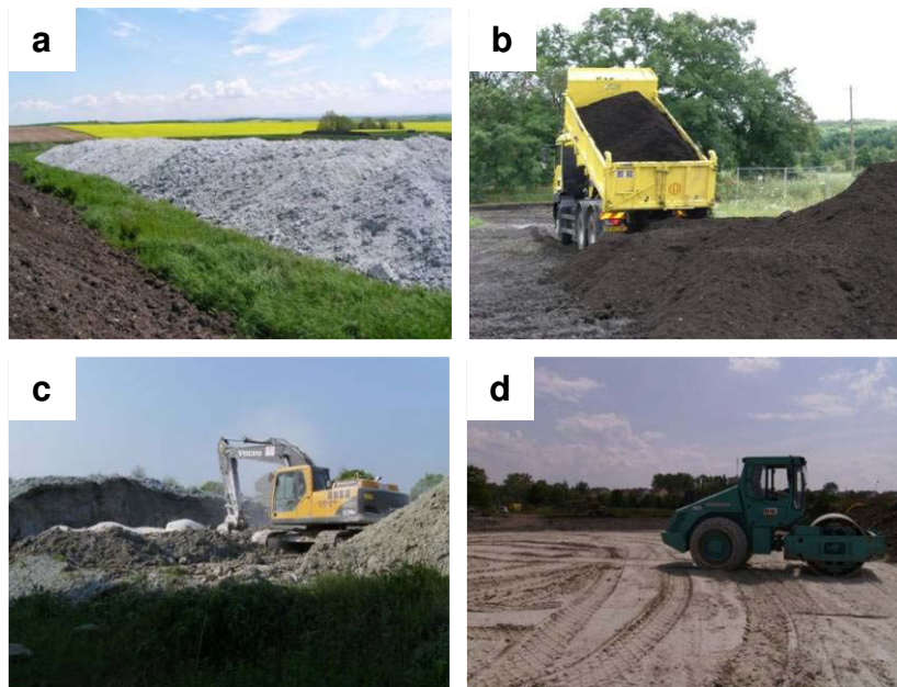
Figure 10. Photographies de la construction de sol, a) boues de papeteries, b) dépôt de compost, c) mélange de terre industrielle et de boues de papeteries, d) nivellage.
