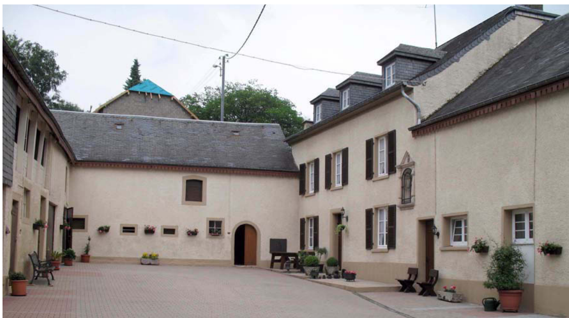
Cliché 41 : La ferme Jean Teischen, une ferme à cour ouverte (juin 2008). Cette ferme est subdivisée en trois parties : la partie d'habitation à droite (elle comporte une niche vitrée qui abrite une statue de la Saint Marie et des lucarnes dans le toit) avec les bâtiments d'exploitation accolés sur la gauche et au centre du cliché. La partie de droite constitue probablement l'origine de cette ferme ; les autres parties ont été rajoutées ultérieurement. La partie centrale était réservée au bétail tandis que la partie de gauche abritait les machines et outillages agricoles. Les parties supérieures des annexes non habitées servaient au stockage de récoltes.
