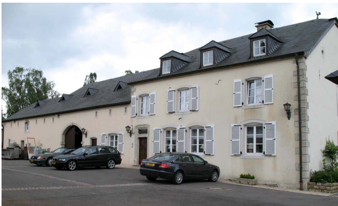
Cliché 31 : Le Schléiwenhaff aujourd’hui (juin 2008). Du Schléiwenhaff traditionnel seul subsiste le bâtiment principal comportant la partie réservée aux hommes ainsi que la grange accolée avec ses étables. Le cadre de la porte ainsi que le mur pignon affichent encore la date de construction : 1768. Outre la résidence privée du propriétaire, la ferme de style dit de Marie-Thérèse abrite aujourd’hui également son entreprise de vente et d’installation de cuisines professionnelles.
