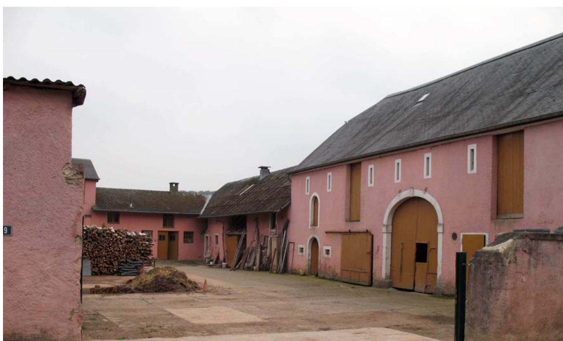
Cliché 42 : La ferme Jean-Pierre Hemmer, une ferme à cour fermée (juin 2008). Malgré l'aspect de cour fermé, cette ferme est traditionnellement une ferme à bâtiments parallèles, le bâtiment à l'arrière-plan et le mur au premier plan ayant été rajoutés tardivement. La maison d'habitation, non visible sur la gauche du cliché est une maison typique du style dit de Marie-Thérèse avec étables et greniers à foin. La partie visible sur la droite du cliché sont d'autres étables, une grange ainsi que d'autres parties abritant la machinerie agricole, le tout étant surplombé d'espaces de stockage des récoltes. La cour intérieure servait traditionnellement à l'entrepôt des outillages agricoles et à l'emplacement du tas de fumier. Comme les autres fermes analysées, la taille de celle-ci reflète également la richesse locale de l'agriculture traditionnelle fondée sur l'élevage.
