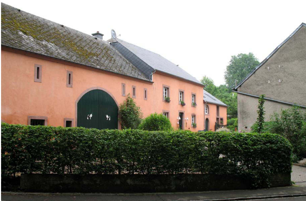
Cliché 40 : La ferme Pierre Hemmer de nos jours (juin 2008). Cette ferme, du même type que la ferme de Nicolas Berg, sépare clairement le corps de logis des parties réservées à l'exploitation agricole. A chaque partie est réservée un toit propre. Cette séparation nette montre une certaine fierté des propriétaires qui ne désiraient plus « partager le même toit avec le bétail ». Généralement appelées maisons de style dit de Marie-Thérèse, ces fermes sont caractéristiques du XVIIIe siècle, époque prospère sous l'impératrice autrichienne Marie-Thérèse.
