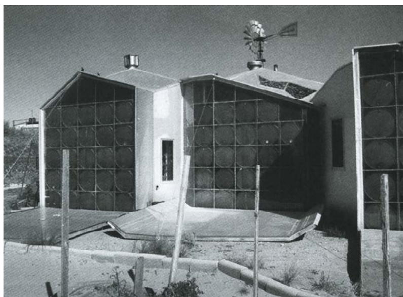
Figure 26. Maison de Steve Bear, Corrales, Nouveau Mexique, vue extérieure des murs d'eau. (Mazria 2005)
