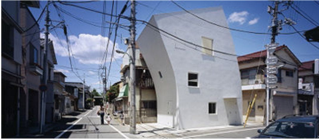
Figure 62. Maison Mosaïc, TNA Architect, Tokyo, Japon, 2006
