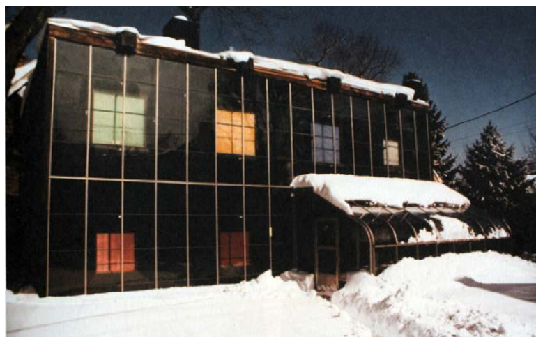
Figure 25. Mur Trombe et serre de la maison Kelbaugh, 1976. (Mazria 2005)
