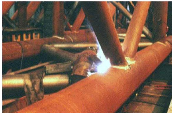
*Figure 1-2 : Soudage des éléments tubulaires d'une plateforme offshore*
