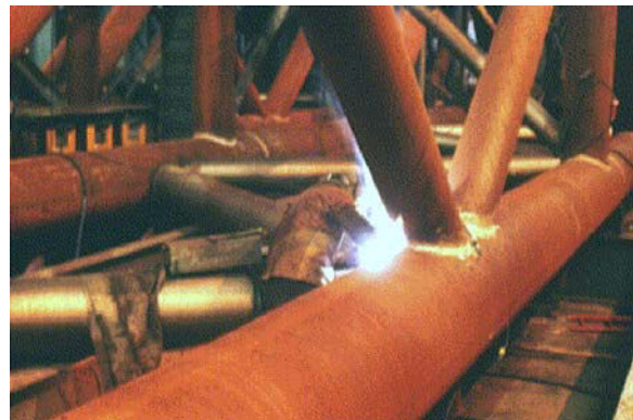
Figure 1-2 : Soudage des éléments tubulaires d'une plateforme offshore
