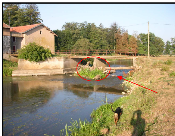
Photo n°18: Ponts, endroit idéal pour des accumulations d'embâcles
