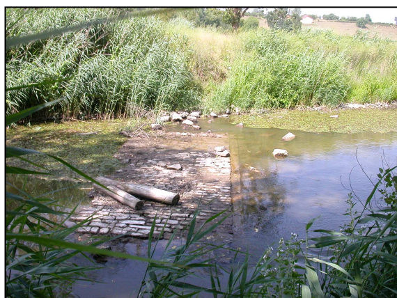
Photo n°27: Fixation du lit mineur au niveau de Marsal
