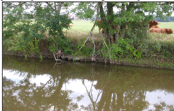
Photo n°35: Exemple de berge végétalisée au niveau de Sillegny (aval de la Seille)
