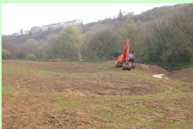
Photo n°41: Rectification du tracé de la Seille (partie amont de la Seille)
