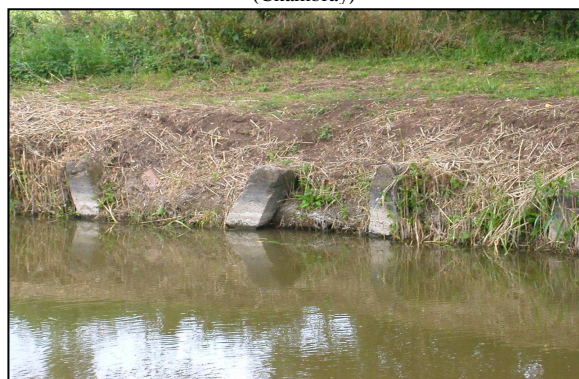
Photo n°33: Exemple d'aménagement avec la technique des poteaux au niveau de Sillegny (partie aval)
