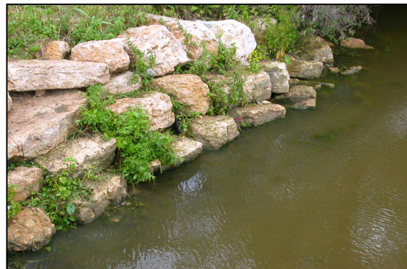
Photo n°32: Exemple d'enrochement à l'aval de la Seille (Chambray)
