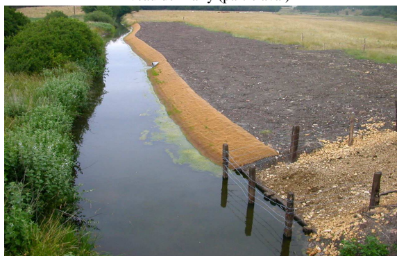
Photo n°31: Exemple d'aménagement avec la technique géotextile au niveau de Marsal.
