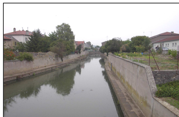
Photo n°38: Exemple du calibrage du tracé au niveau de Coin-sur-Seille (partie médiane)
