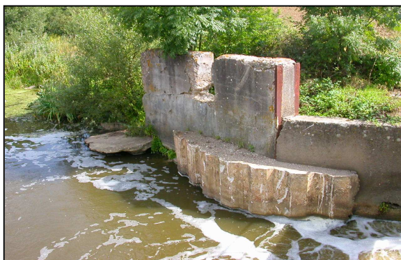
Photo n°29: Exemple d'une digue de protection des berges au niveau de Sillegny
