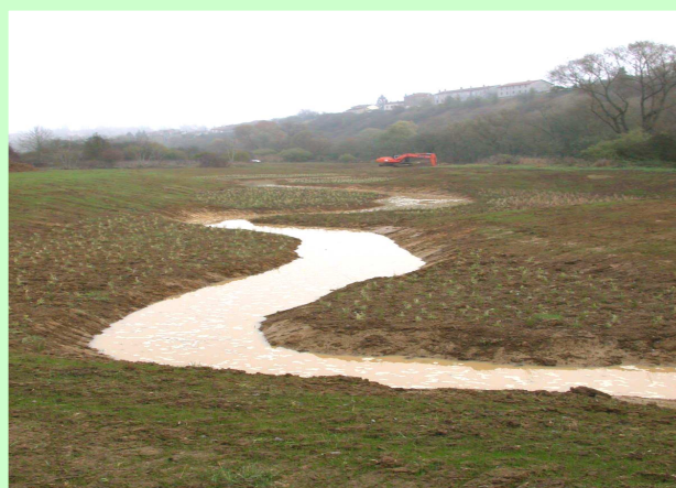
Photo n°42: Création des méandres à l'aval de Dieuze (partie amont de la Seille)
