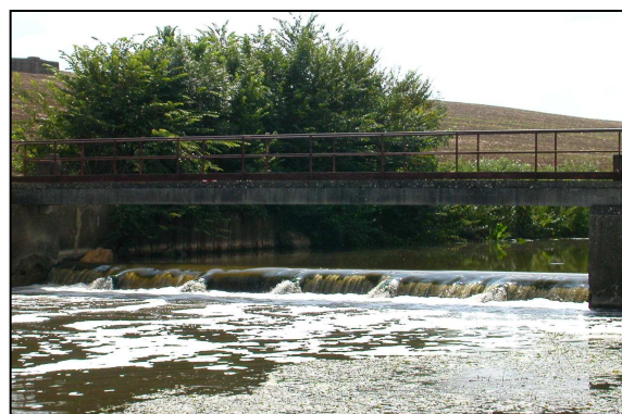
Photo n°36: Exemple d'un seuil construit au niveau de Cheminot
