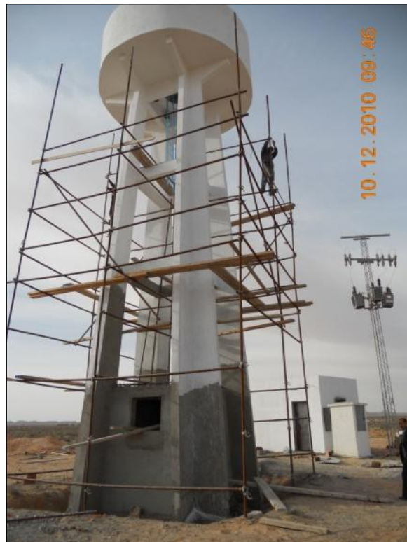
Photo 1. Construction d'un réservoir d'irrigation dans l' imada de Menzel Habib en 2010 (Mzioudet, 10/12/2010)
