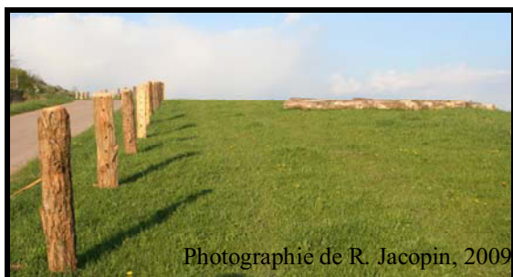
Photo 83 : Mise en place d'une nouvelle clôture à Domèvre-sous-Montfort
