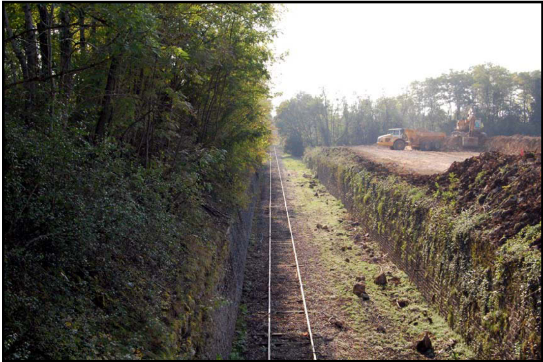
PHOTO 69 : LA LIGNE BESANÇON-VESOUL AVANT LES TRAVAUX
