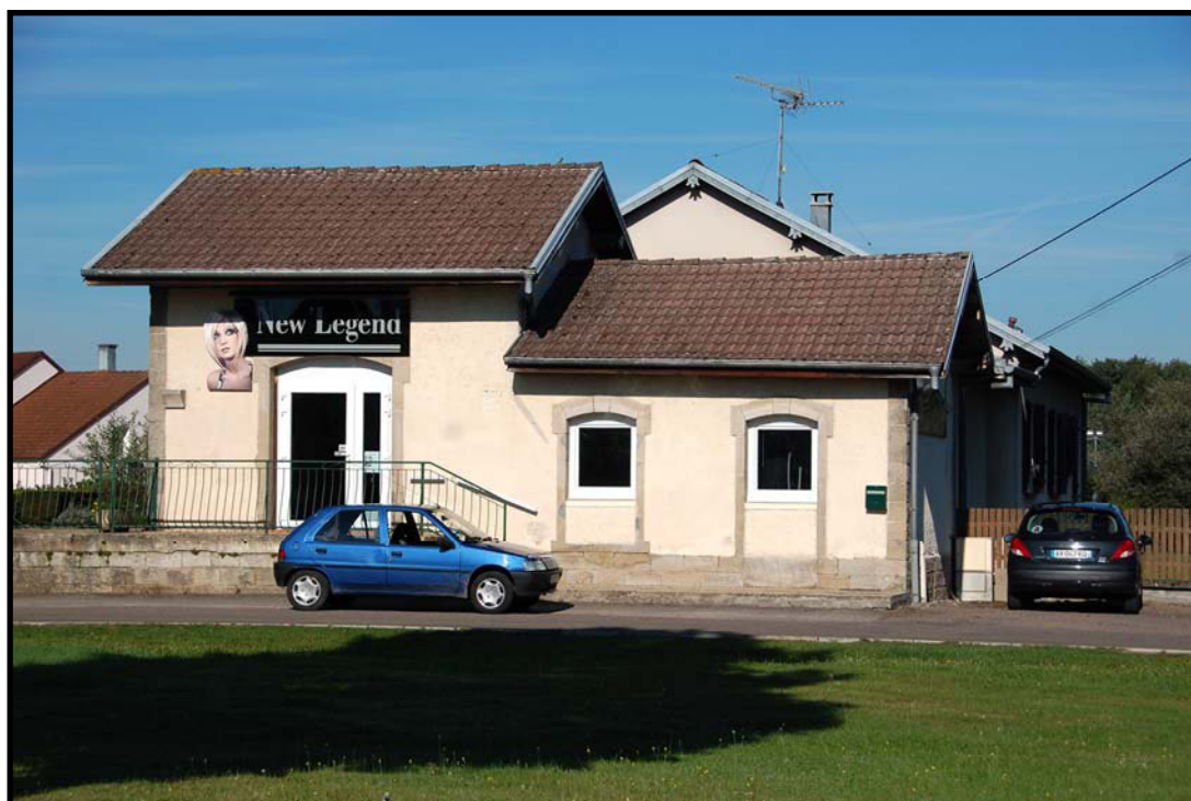
PHOTO 39 : LA GARE DE BREUCHES-LES-LUXEUIL
