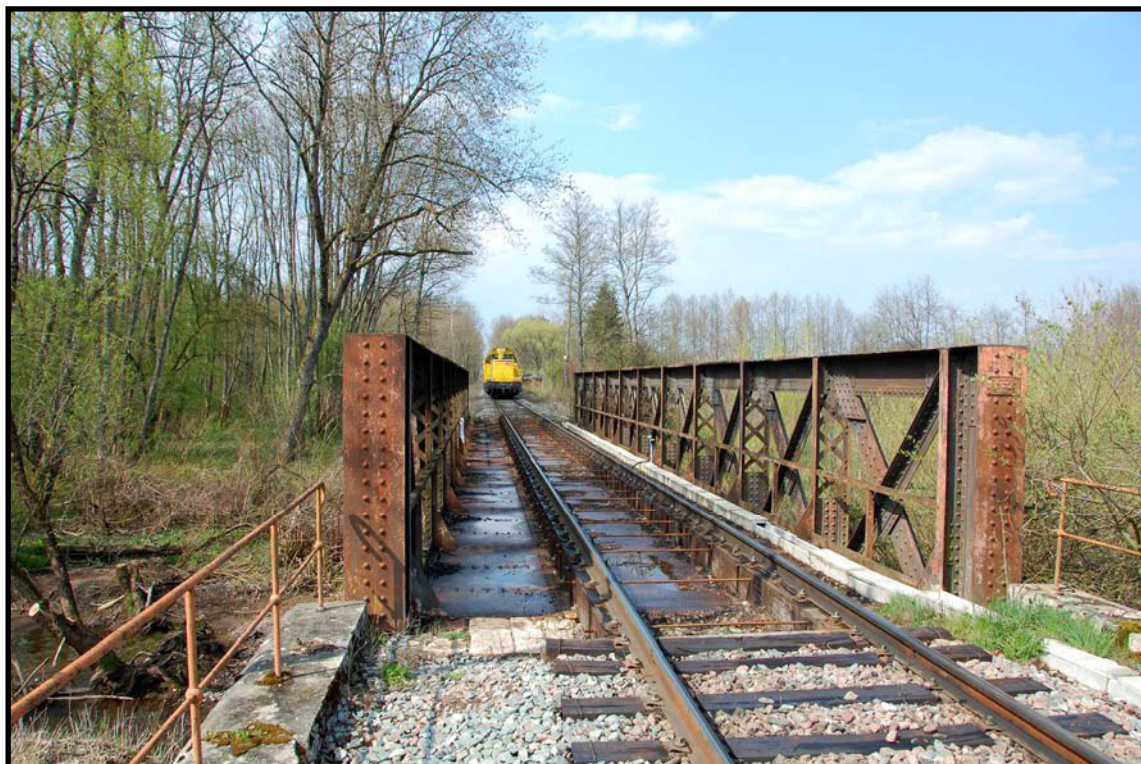
PHOTO 64 : LA LIGNE DE LURE A VILLERSEXEL EN 2010
