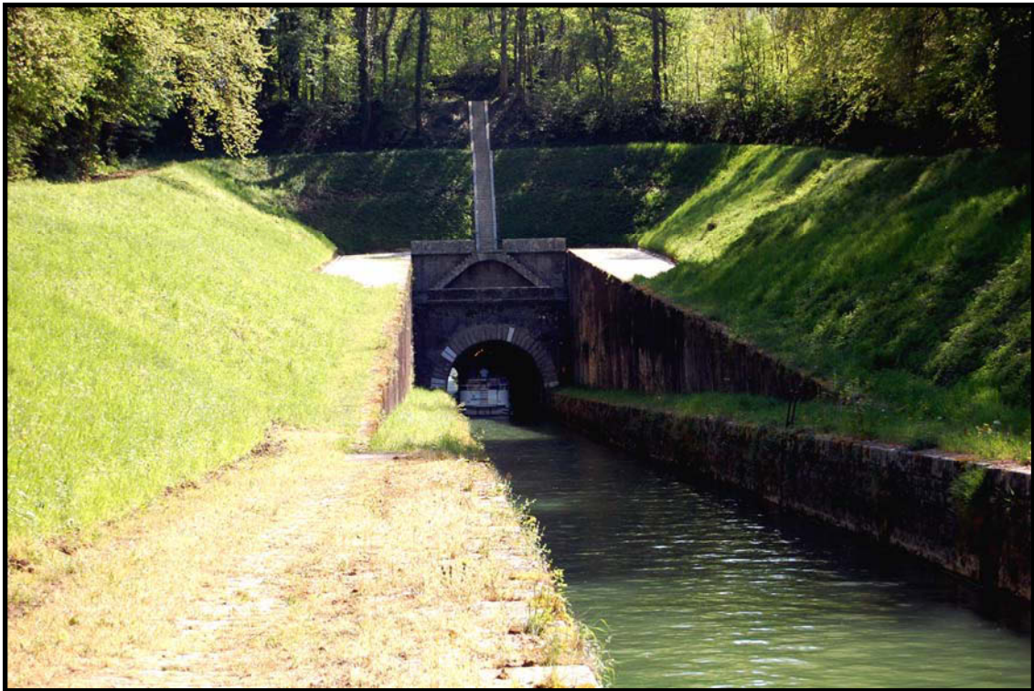
PHOTO 10 : TUNNEL FLUVIAL DE SAVOYEUX
