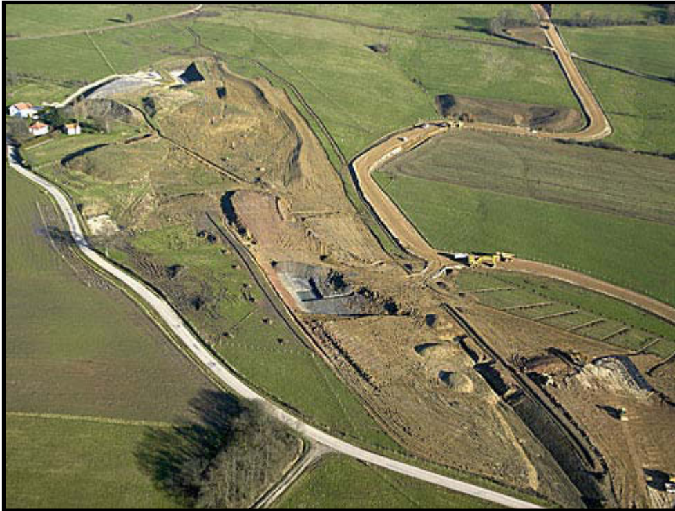
PHOTO 74 : LE DEBUT DU CREUSEMENT DU TUNNEL DE CHAVANNE
