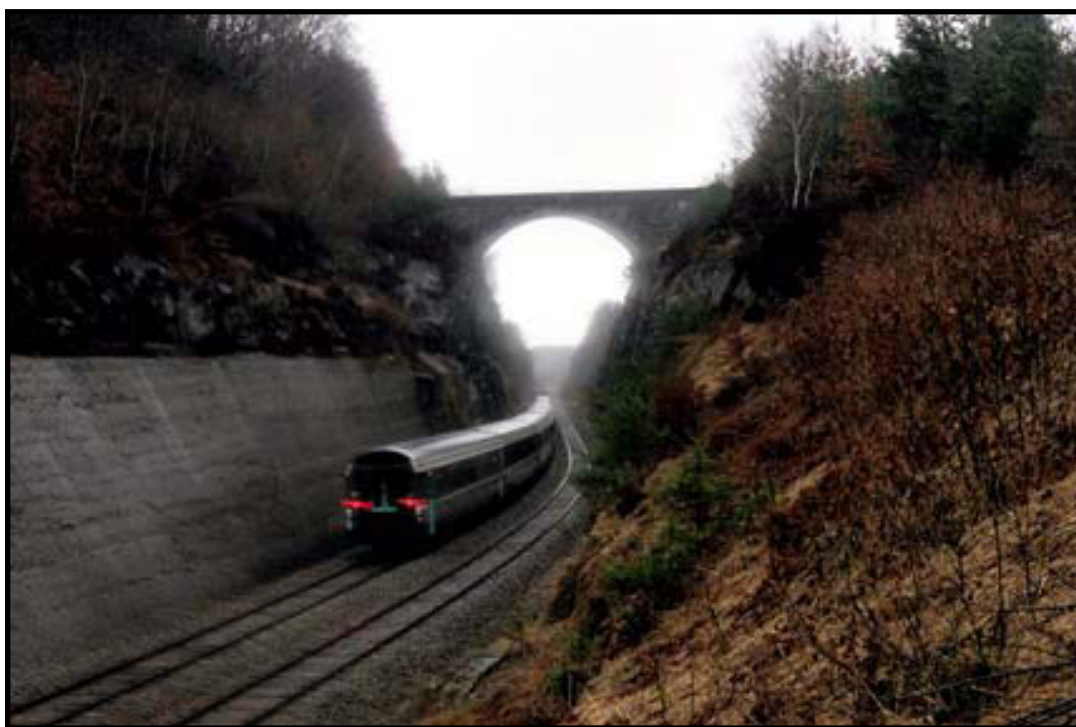
PHOTO 26 : LA TRANCHEE DU PONT NAPOLEON ENTRE DOUNOUX ET XERTIGNY
