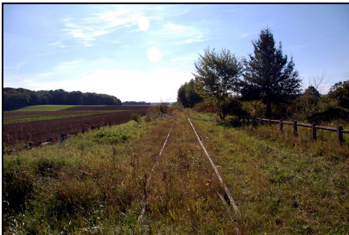
PHOTO 93 : L'ANCIENNE LIGNE DE VESOUL-GRAY
