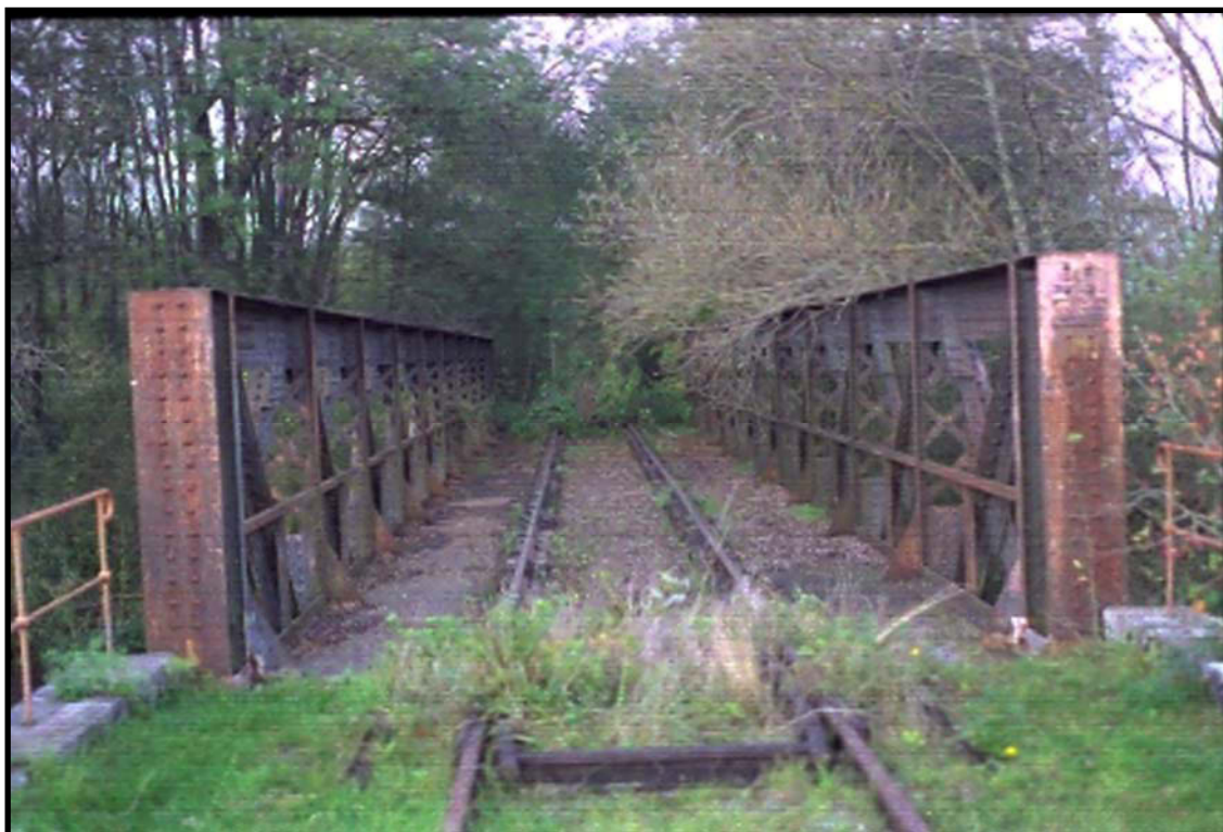
PHOTO 63 : LA LIGNE DE LURE A VILLERSEXEL EN 2006
