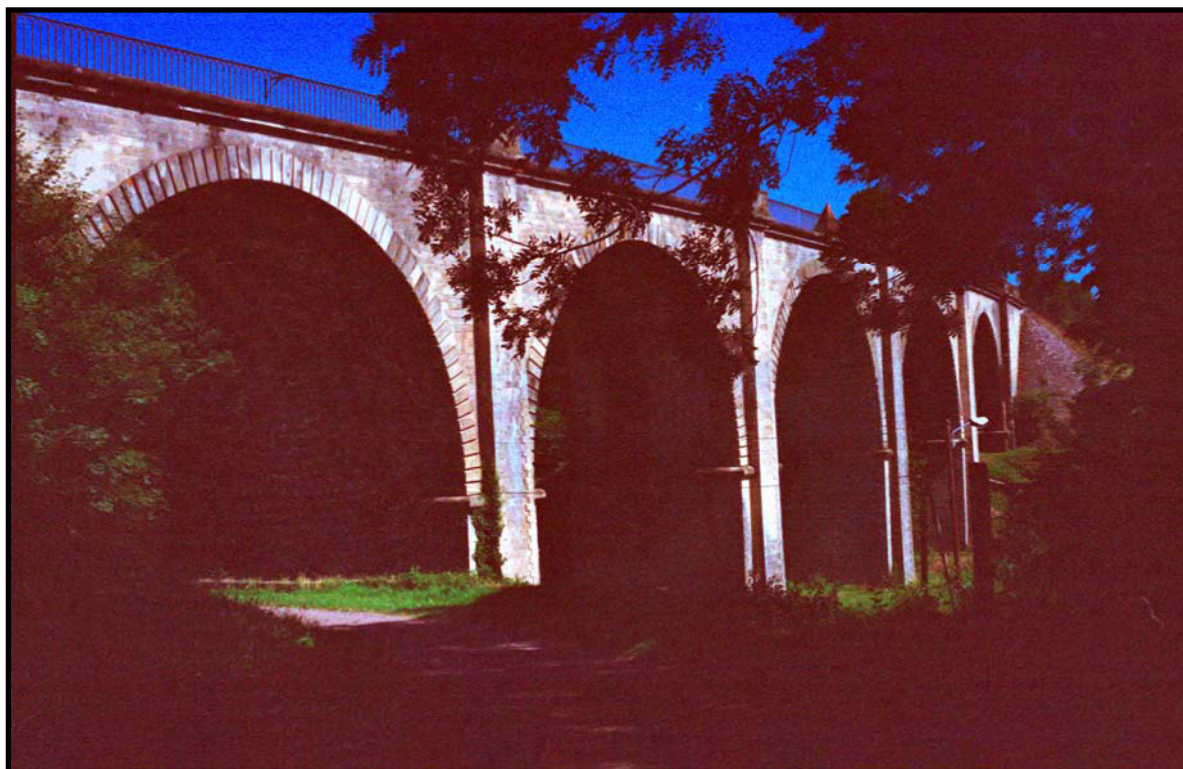
PHOTO 46 : LE VIADUC DE PASSAVANT-LA-ROCHERE
