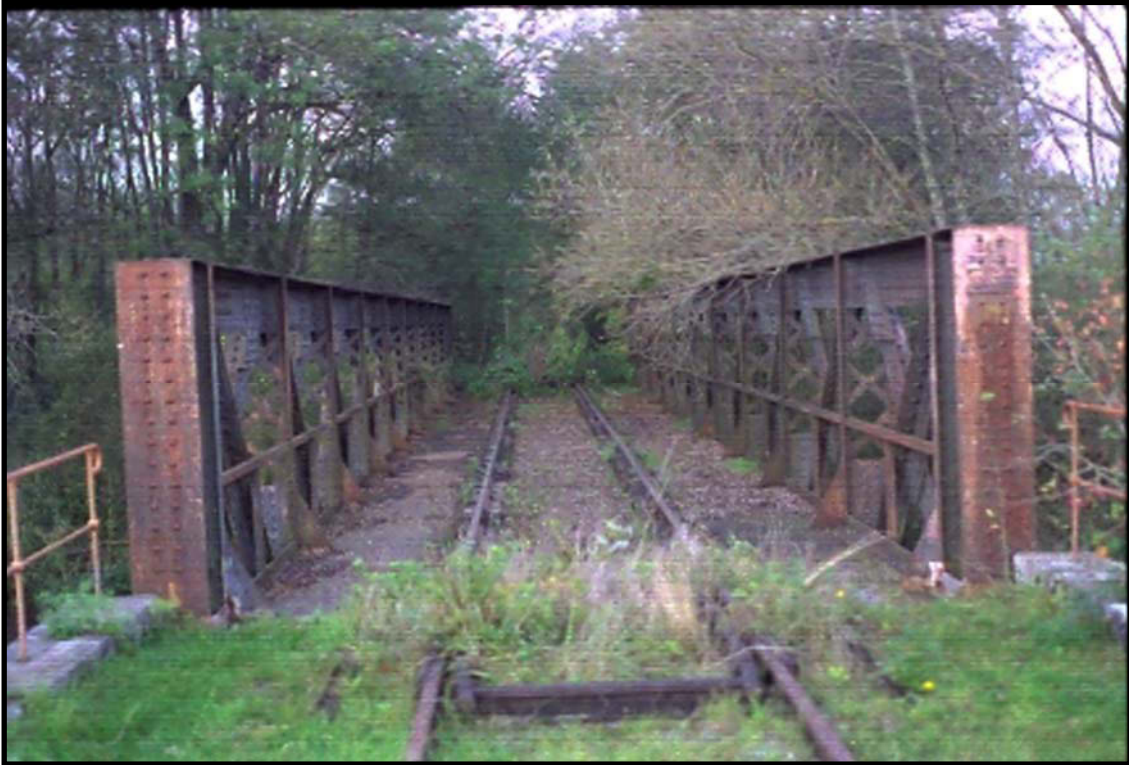
PHOTO 63 : LA LIGNE DE LURE A VILLERSEXEL EN 2006
