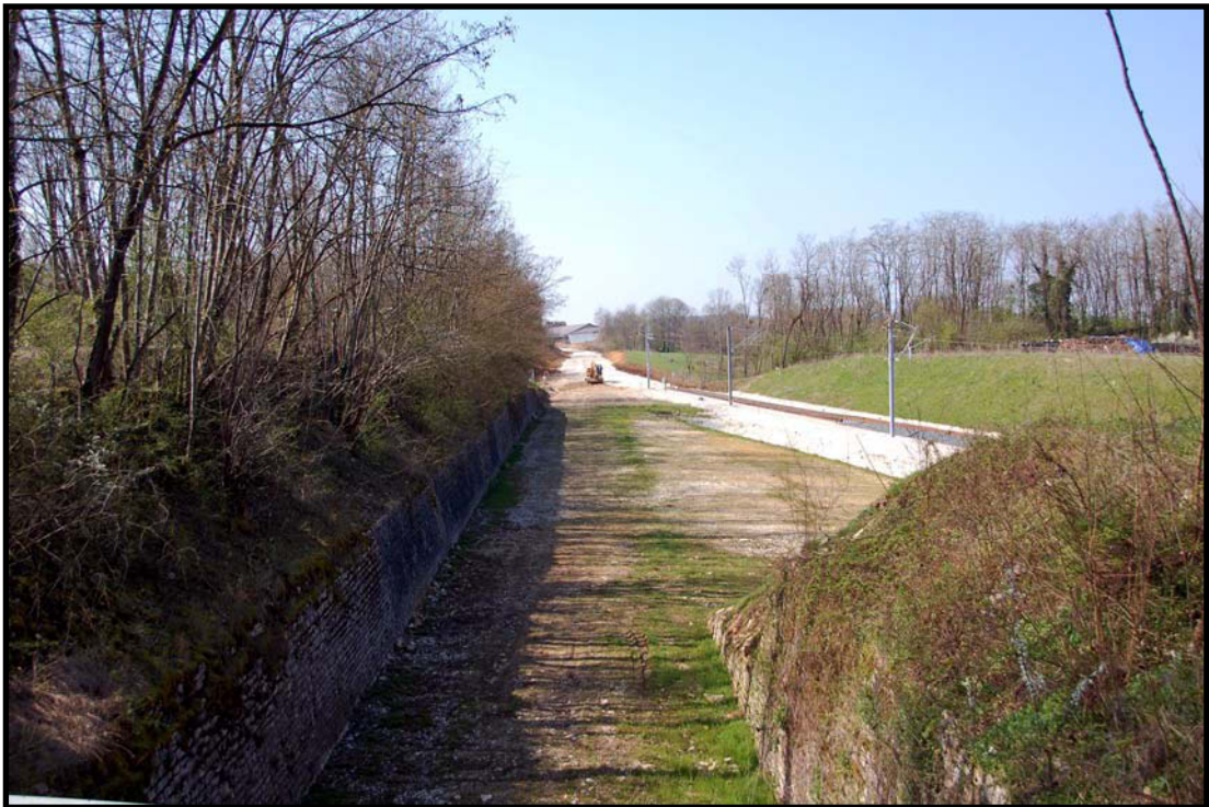
PHOTO 70 : LA LIGNE BESANÇON-VESOUL A LA FIN DES TRAVAUX
