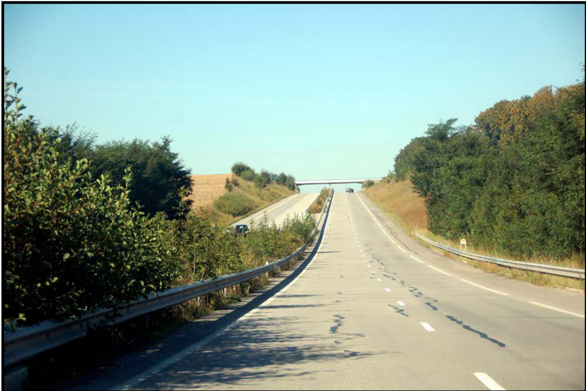
PHOTO 94 : LA LIGNE ÉPINAL-MIRECOURT
