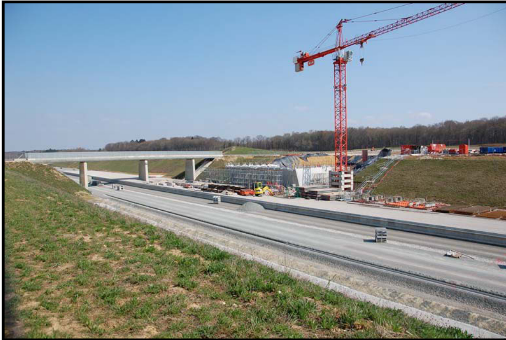
PHOTO 86 : LE DEBUT DU CHANTIER DE LA GARE DE BELFORT-MONTBELIARD-T.G.V.
