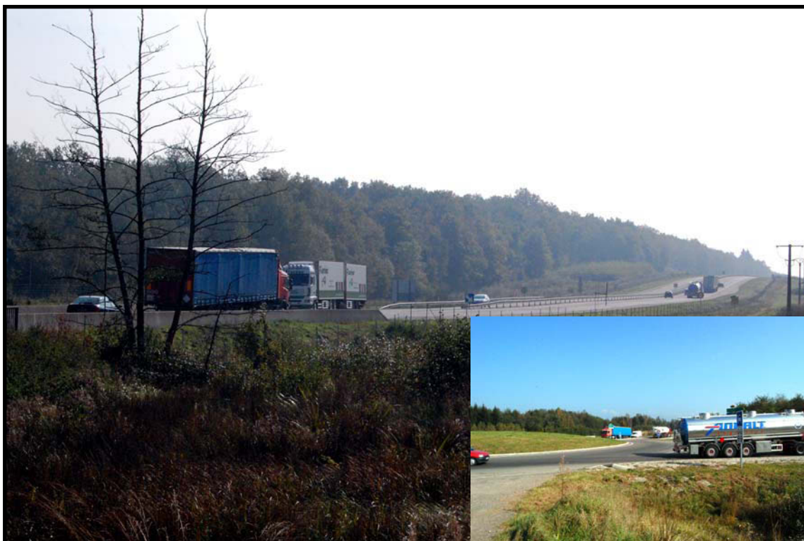
PHOTO 5 : LA R.D.64 A LUXEUIL-LES-BAINS
