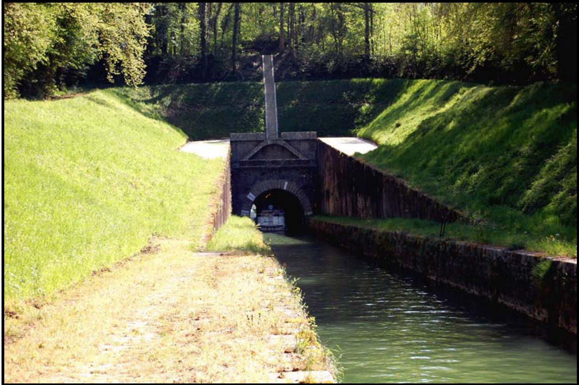
PHOTO 10 : TUNNEL FLUVIAL DE SAVOYEUX
