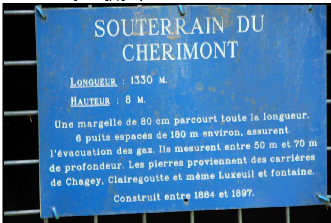
PHOTO 19 : PLAQUE INFORMATIVE DU TUNNEL
