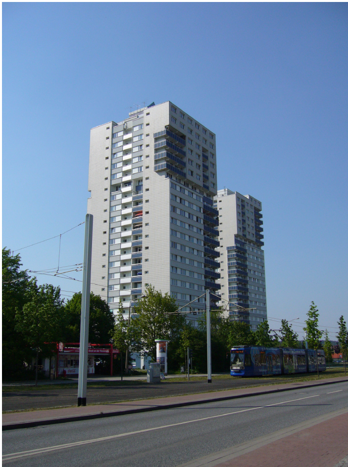
Photo 12. Les tours qui ferment la Magistrale à l'ouest
