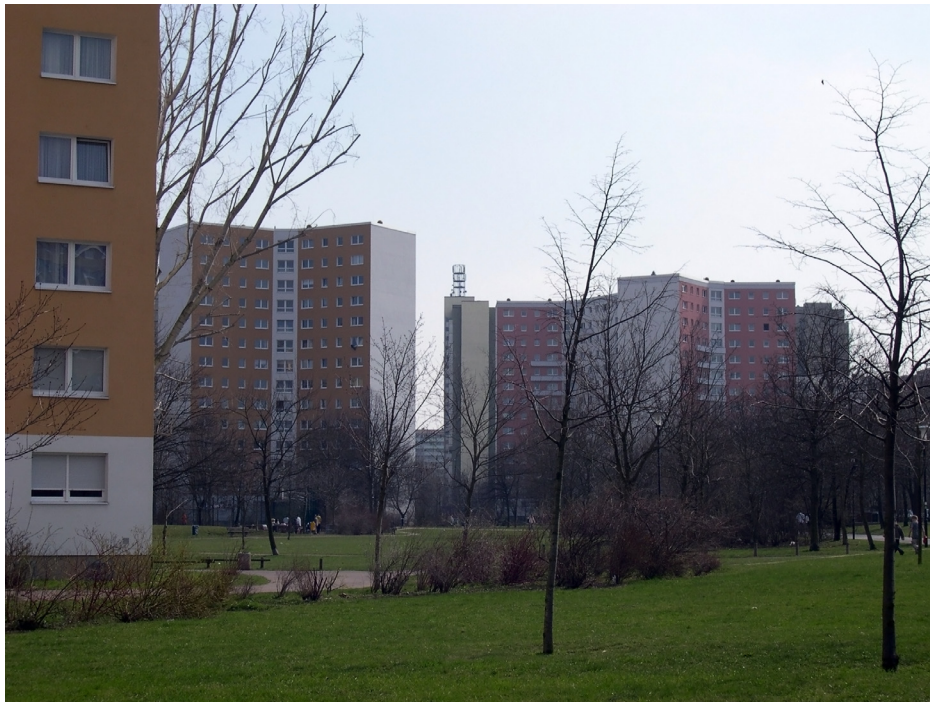
Photo 11. Les tours du complexe IV
