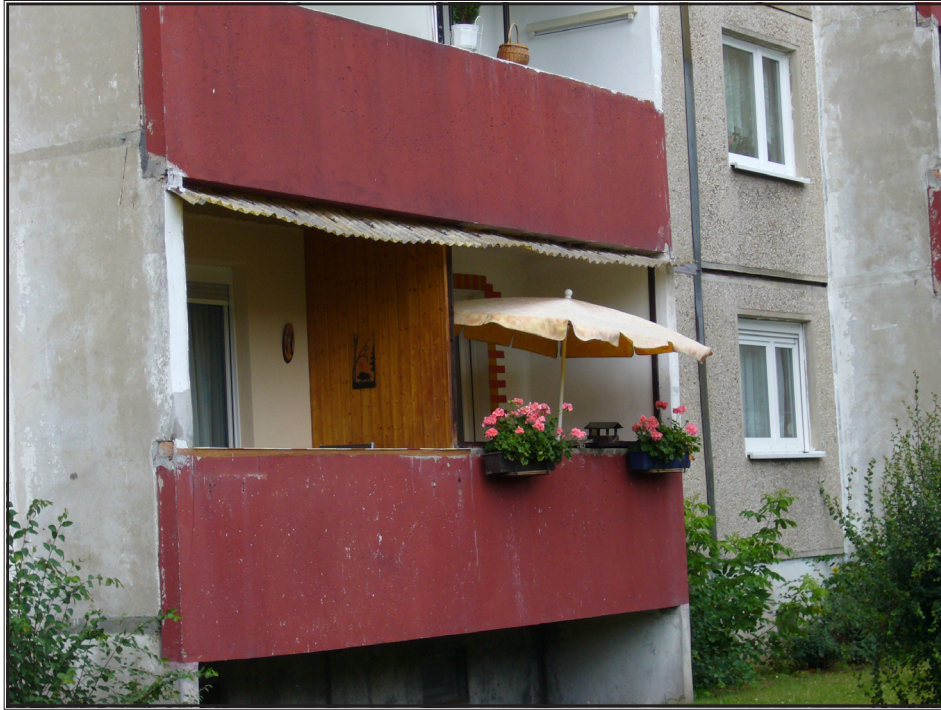
Photos 19 et 20. Immeubles à la façade non réhabilitée, complexe VI
