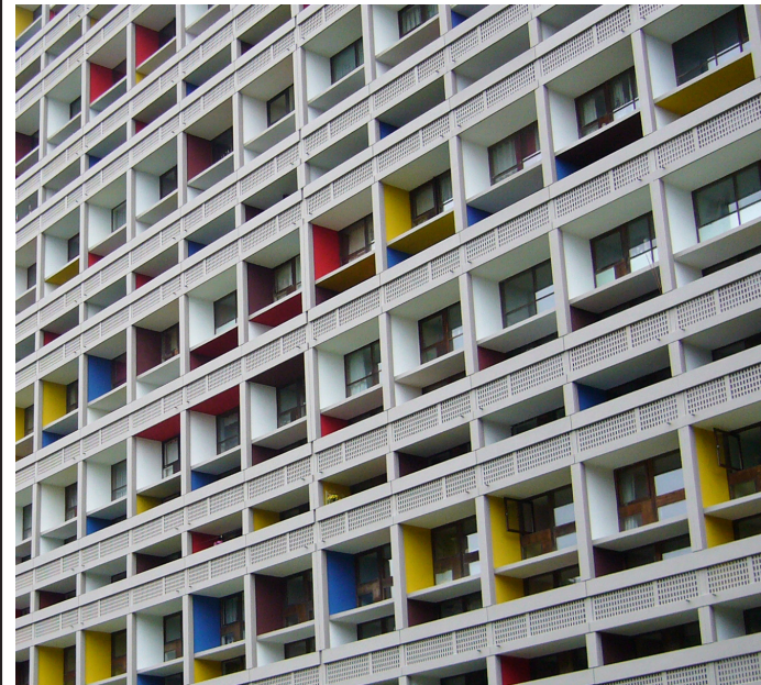
Photo 3. Façade de la Cité Radieuse de Briey
