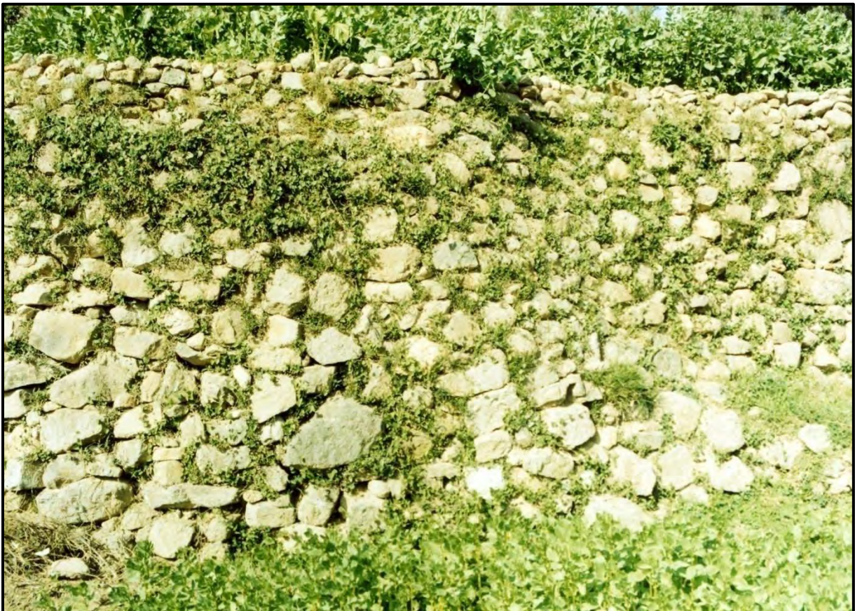
Cliché 2. Mur de soutènement d'une terrasse de culture irriguée, dont on peut remarquer que la végétation a poussé entre les pierres. Bassin de Tanalt. Cliché : M. Ziyadi, mars 2006.
