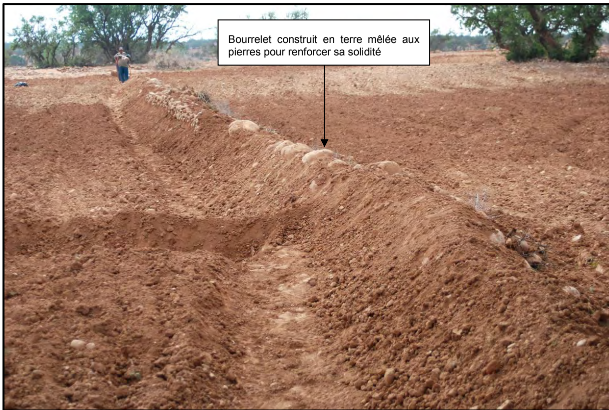
Cliché 59. Détail d'un talus et d'un canal secondaire en cours d'élaboration dans les terres faïd , douar Tagant sur l' oued Arghene. Cliché : A. Humbert, octobre 2008.
