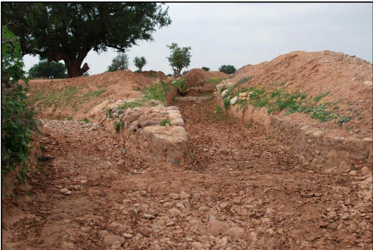
Cliché 51. Exemple d'amélioration apportée à la construction des séguia(s) faïd . Rive gauche de l' oued Arghene. Cliché : M. Ziyadi, octobre 2008.
