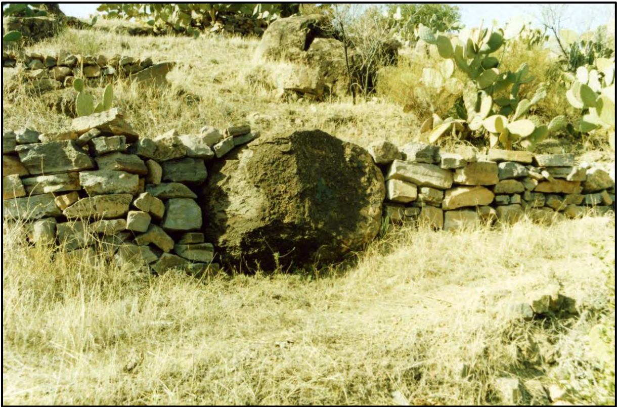
Cliché 21. Structure d'un muret de soutènement d'une terrasse "sèche" abandonnée. Une pierre volumineuse fait partie intégrante du muret. Versant de la vallée de Takoucht, commune rurale de Tanalt. Cliché : M. Ziyadi, 2006.
