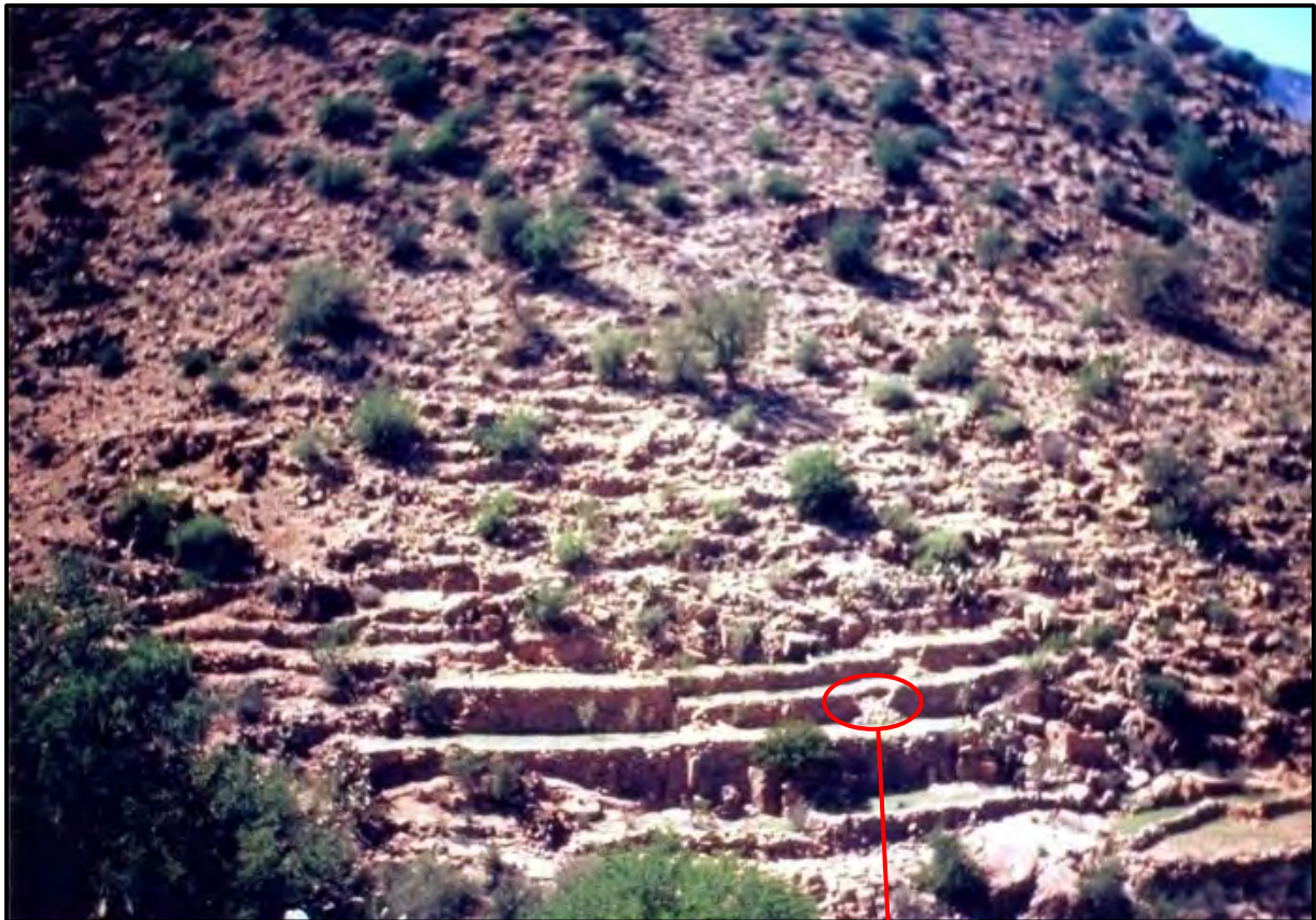
Cliché 93. Murets de soutènement écroulés. Vallée de Takoucht, commune rurale de Tanalt. Cliché : M. Ziyadi, mai 2004.
