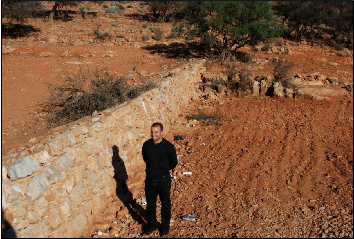
Cliché 37. Muret de soutènement. Douar Id Abd au sud de Tleta LAKhsass. Cliché : A. Humbert, octobre 2008.
