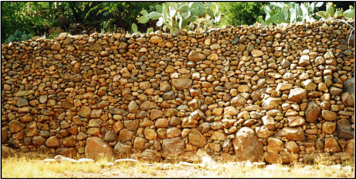
Cliché 13. Structure d'un mur de soutènement. Vallée de Takoucht. Cliché : M. Ziyadi, 2005.
