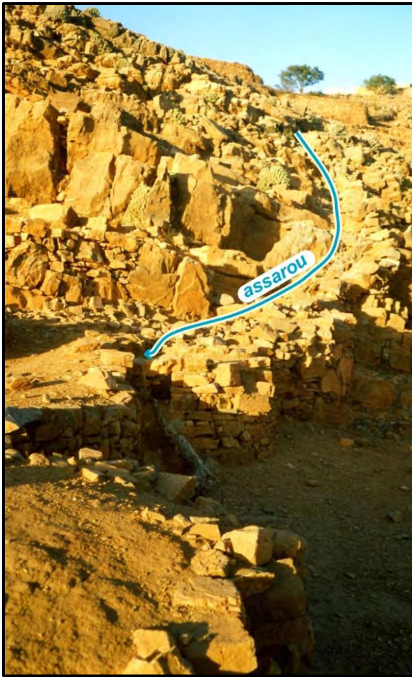
Cliché 84. Détail d'un assarou permettant de conduire l'eau de pluie vers la citerne. Douar Tassdmite, commune rurale de Hilala. Cliché : M. Ziyadi, décembre 2006.
