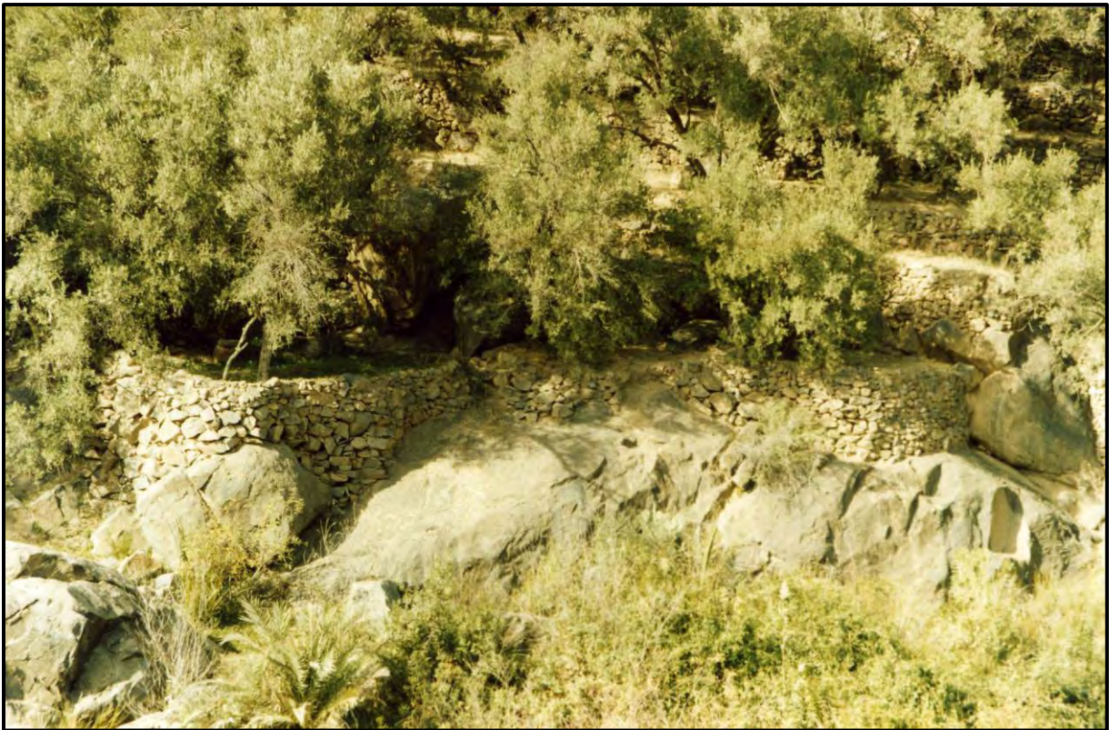
Cliché 5. Détail de murets entièrement établis sur la roche affleurante. Bassin de Tanalt. Cliché : M. Ziyadi, 2006.
