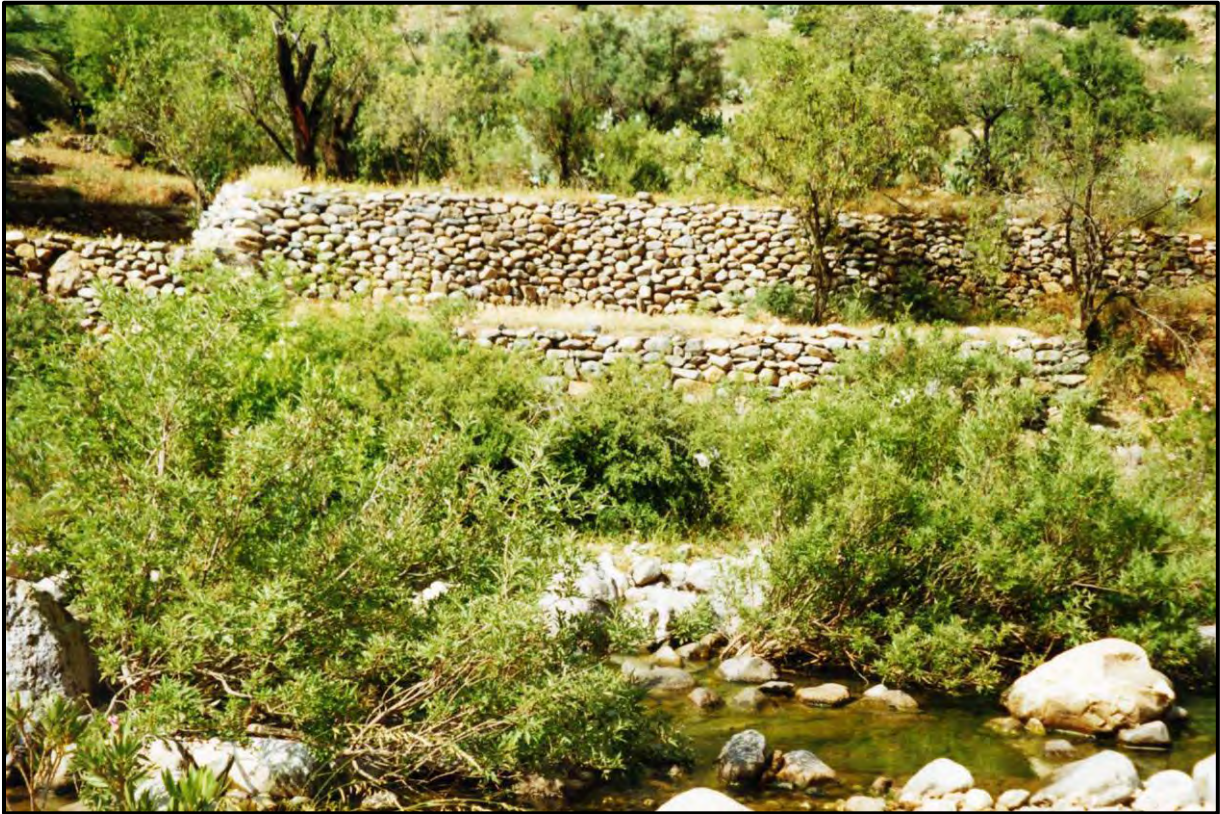
Cliché 14. Structure d'un mur de soutènement de fond de vallée. Vallée de Takoucht. Cliché : M. Ziyadi, 2006.
