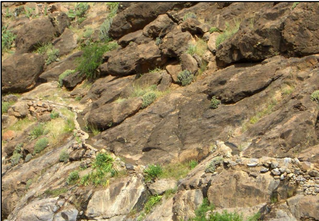
Cliché 9. Séguia établie sur une surface de rocher très irrégulière. Cliché : M. Ziyadi, 2006.
