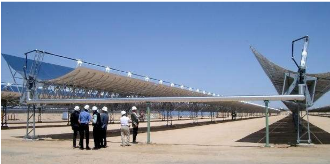
Figure 2.3 : Vue d'une boucle de captage à cylindro-paraboliques de la centrale Andasol-1. On notera le grand rapport longueur / largeur de la boucle, et les raccords articulés au niveau des absorbeurs. (Solar Millenium)
