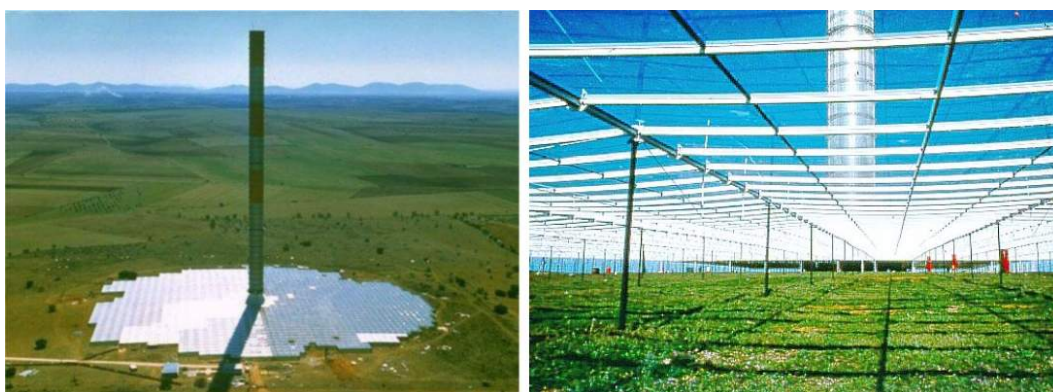
Figure 1.16 : Cheminée solaire expérimentale de Manzanares (Espagne) 195 m de haut, 46000m 2 de capteurs pour une puissance max de 50kWe . A gauche vue globale, à droite vue interne de la serre de captage.(SBP)
