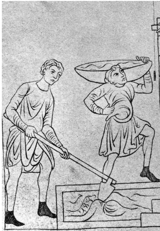
Fig. 30 : Préparation et transport du mortier. Extrait de l' Hortus Deliciarum .
