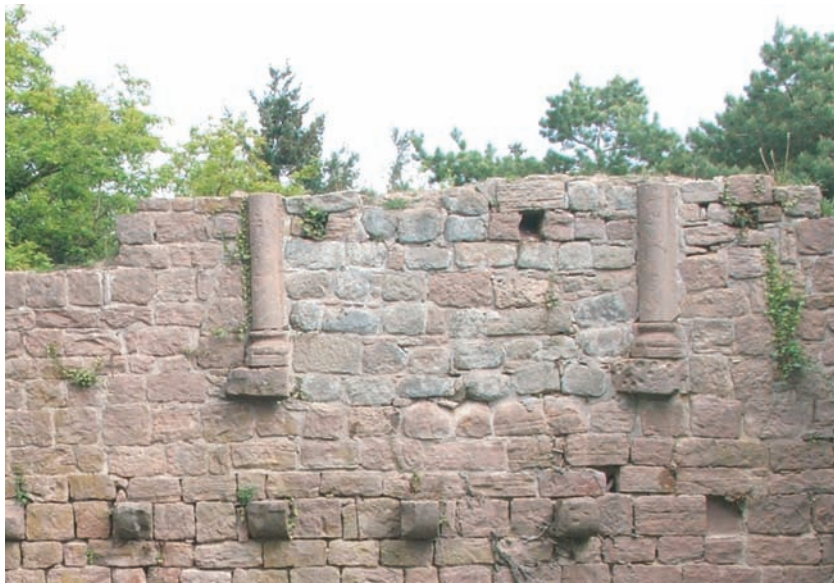
b. Architecture et confort: Dagsburg - logis nord (phase B : milieu du XII e siècle)
