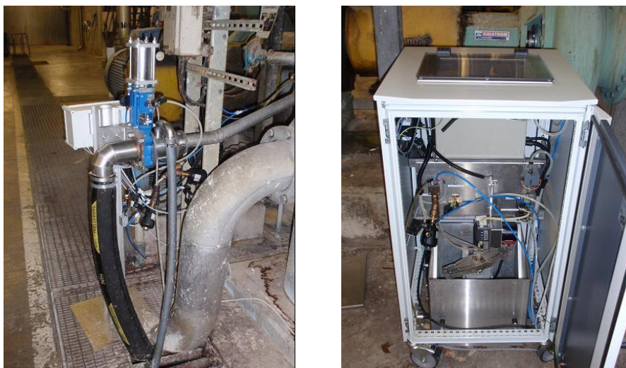
Figure 49 : Photos de l'automate mesurant la turbidité installé en usine
