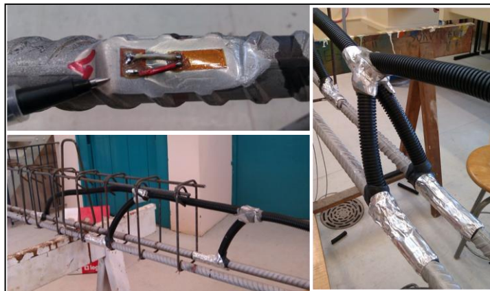
Fig. RE8 Jauges sur les armatures
