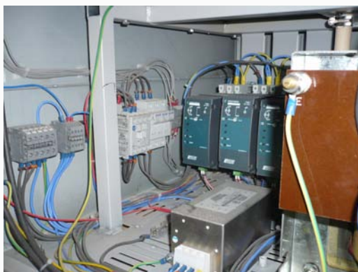
Figure 5.17 – Régulateurs indépendants pour les trois zones de chauffe
