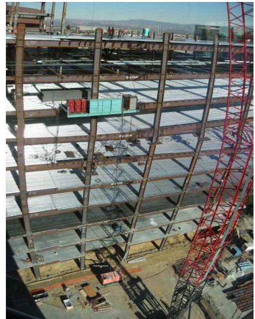
B- Structure métallique aux Etats-Unis
