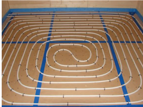
Figure 5.3 : Tube PER en serpentin avant le coulage de la dalle béton
