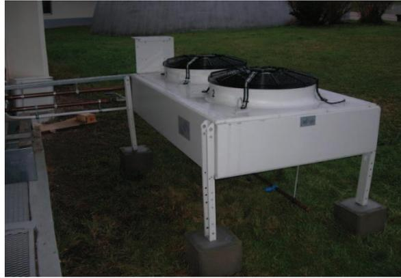
Figure 5.7 : L'aéro-réfrigérant
