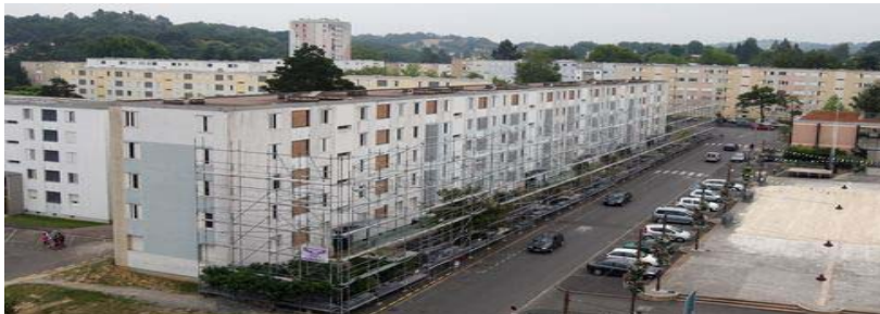
Préparation de la « déconstruction » de l'immeuble O (La République des Pyrénées, 2010)
