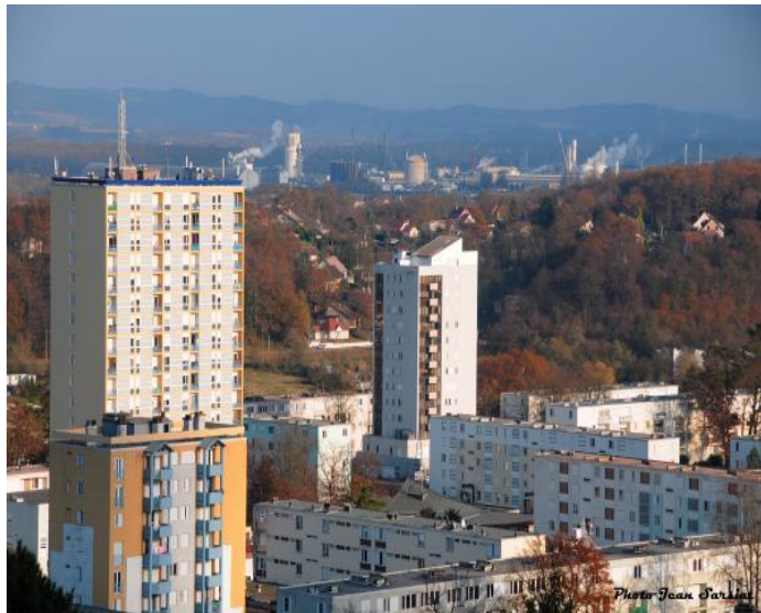
Vue de Mourenx et des usines de Lacq au loin (Communauté de communes de Lacq, 2011)
