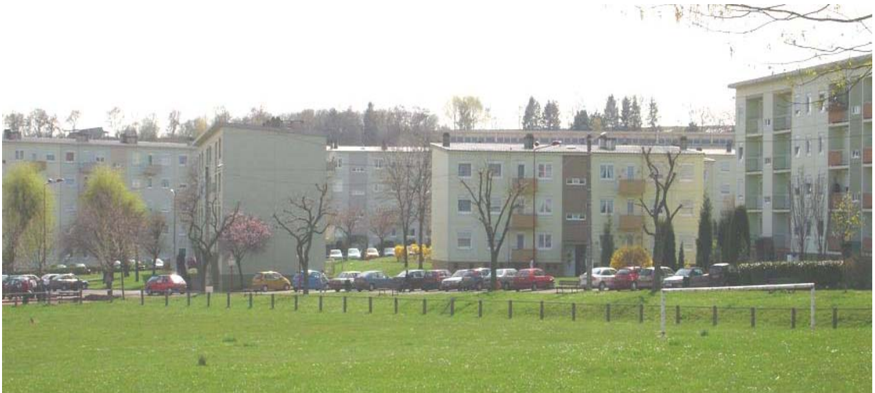
Photo d'une partie de la Cité après réhabilitation (Communauté d'utilisateurs et développeurs Piwigo, 2010)
