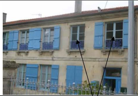
Menuiseries simple vitrage peu perméables
