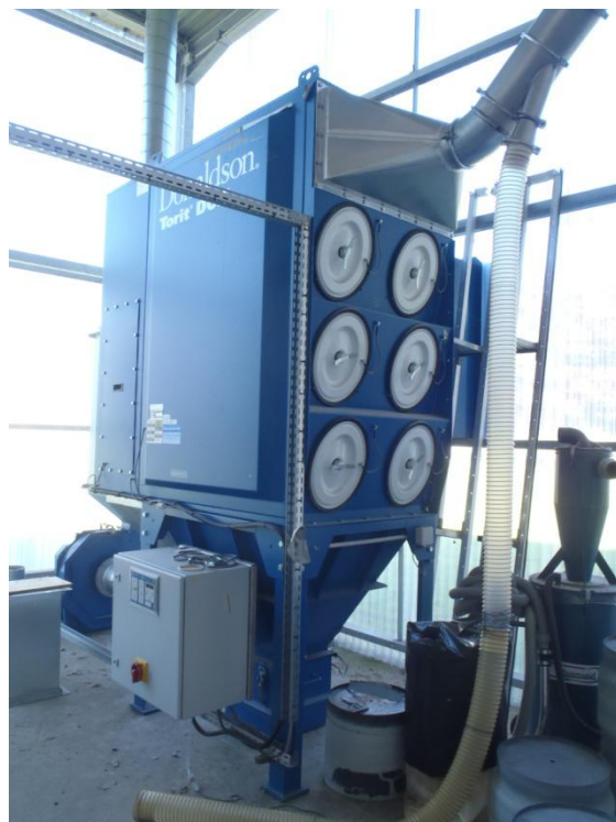
Figure 2.10 : Photo du dépoussiéreur DFO 3-12
