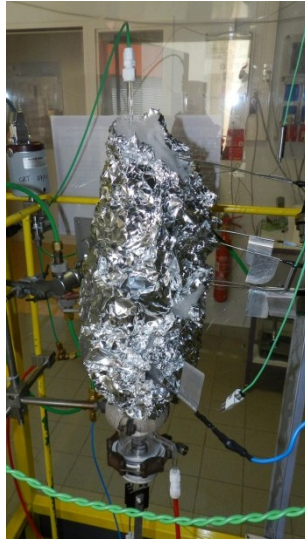
Figure 11 : Photo du RAC calorifugé
