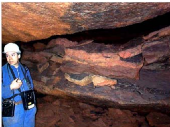
FIGURE 1.9 – Stot de Nondkeil (Ottange) - Exemple de dégradations observées suite à la chute d'un intercalaire (source : GEODERIS).
