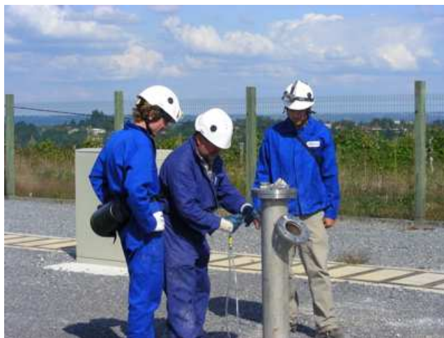
Figure 3.1 : Vue du puits Sentinelle, dédié au monitoring géochimique des gaz du sous-sol sur le site de Rousse 1, pilote CO 2 Total, Lacq-Rousse, Pyrénées-Atlantiques.
