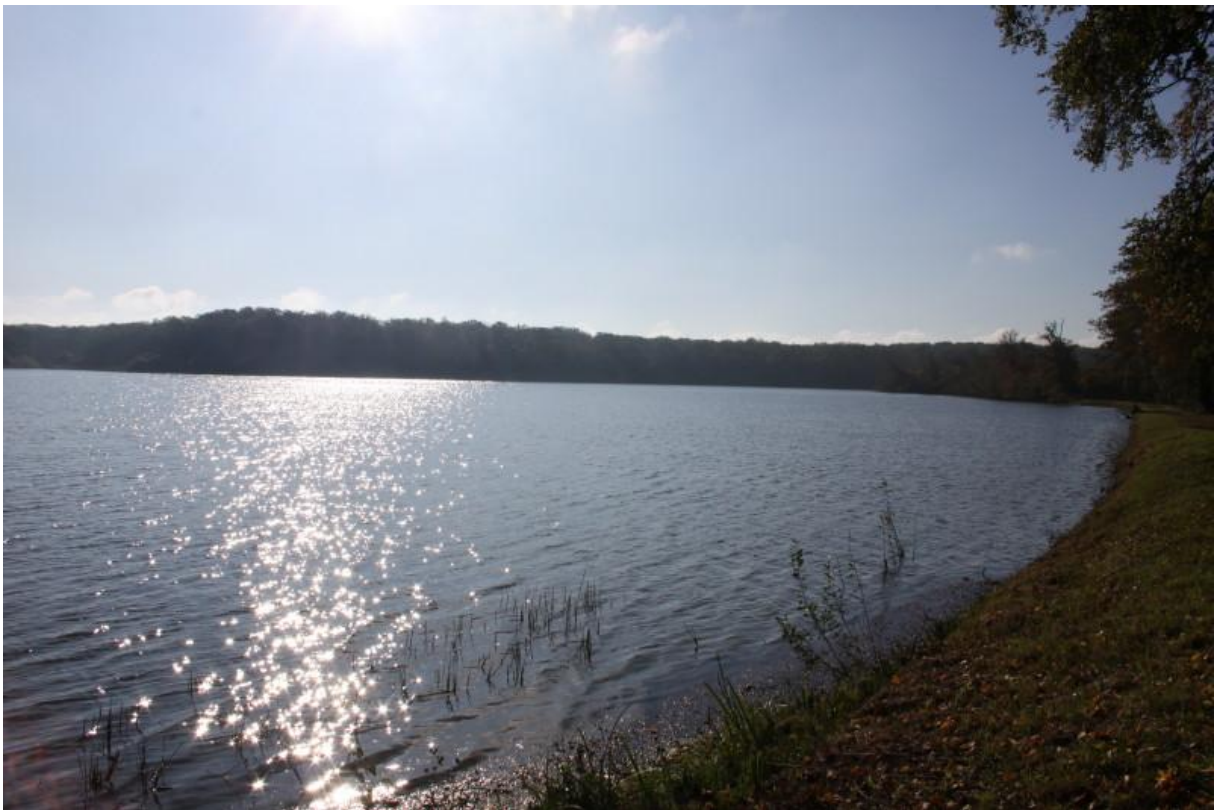
Photographie prise de la digue de l'étang de Lansquenet (Moselle).
