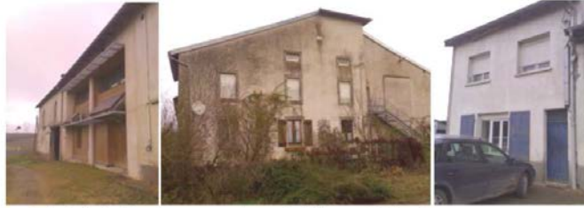
Figure 5 – De gauche à droite : les façades ouest, sud et est du bâtiment N°2 du site
