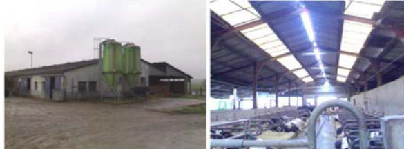
Figure 6 – L'extérieure et l'intérieure du bâtiment N°3 du site
