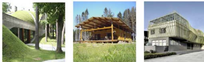
Annexe 1 - 2 - Trois exemples d'icône représentant les cas de réalisation : (du gauche à droite) Centre d'éducation d'Eupos Parkas à Vilnius, Maison individuelle à Saint-Rémy, Maison individuelle à Han-i-Ian (collecte et adaptation par notre recherche)
