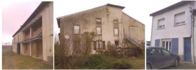
Figure 5 – De gauche à droit : les façades ouest, sud et est du bâtiment N°2 du site
