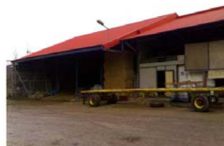
Figure 4- Le bâtiment N°1 destiné au stockage des machines
