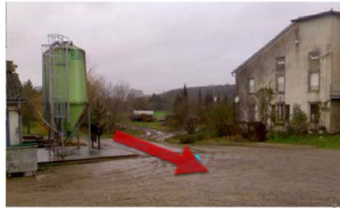
Figure 2- L'entrée actuelle du site
