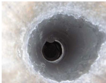
Figure A-IV.3 : Intérieur du four tubulaire après tests de pulvérisation
