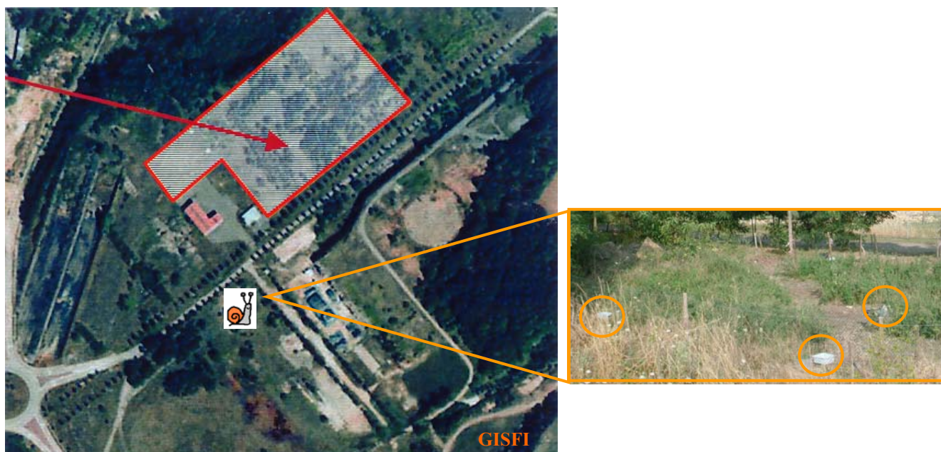
Figure 9 : Vue aérienne du site de l'ancienne cokerie d'Homécourt (54), avec encadrée en rouge, la future zone d'implantation des dispositifs lysimétriques, et la localisation des microcosmes installés sur la parcelle du LIMOS
