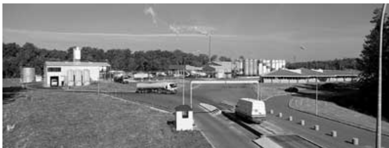
Figure 13a : Vue générale du site de CEDILOR avec la cheminée de l'évapo-incinérateur au milieu
