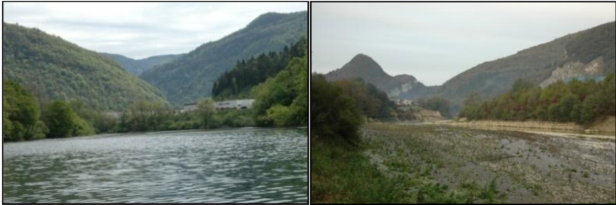
Fig.11 : Photographies du barrage d'Etalles (Bienne) avant la vidange et après, avant la remise en eau de la retenue. Source : Colas F.
