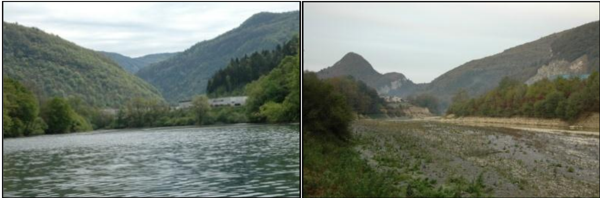
Fig.11 : Photographies du barrage d'Etalles (Bienne) avant la vidange et après, avant la remise en eau de la retenue. Source : Colas F.
