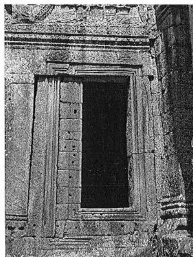
Ph. 220 : Porte Sud de la loggia Sud-Ouest de la tour BY.39
