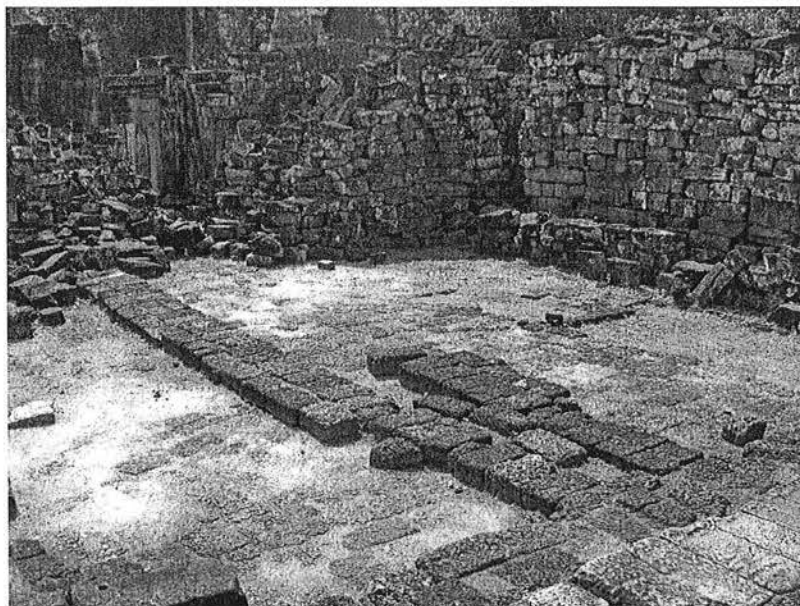
Ph. 247 : Alignement de blocs de latérite dans l’angle Nord-Ouest de la cour intérieure du premier étage du Bayon
