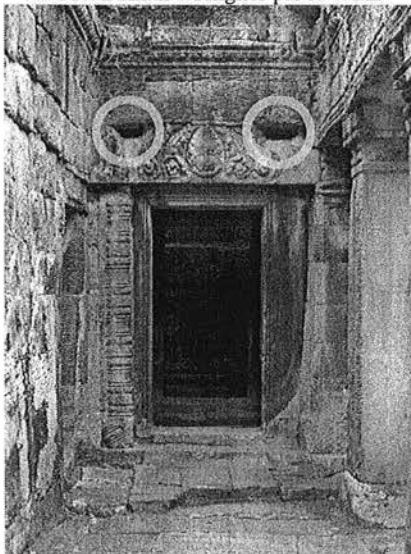
Ph. 28 : Exemple de pillage de crampons de linteau décoratif par l'extérieur
