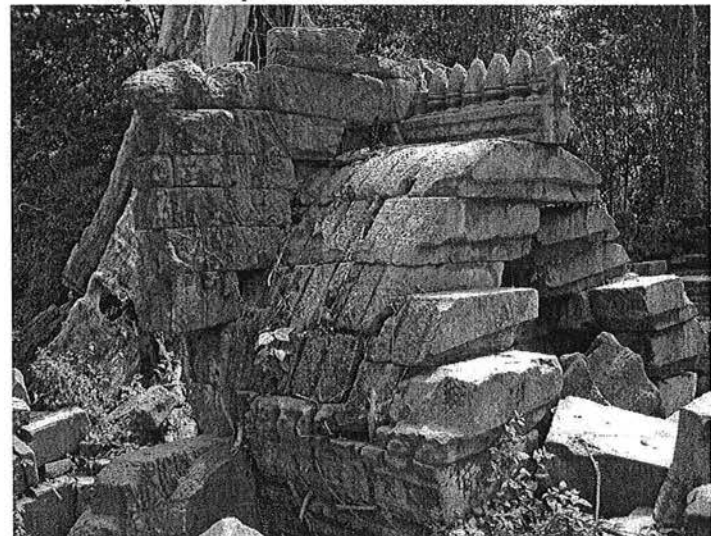
Ph. 235 : Adjonction d'un nouveau fronton sur le pavillon d'angle PK.39 de la première enceinte du Preah Khan d'Angkor
