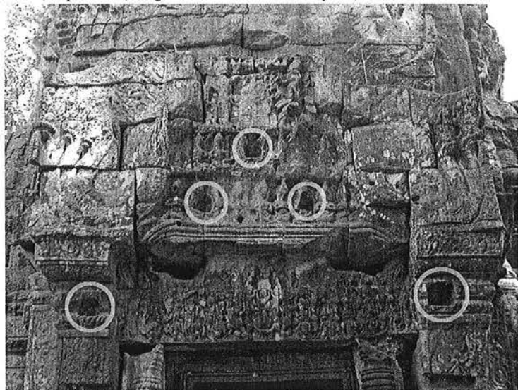
Ph. 120 : Exemple de traces d'appentis rajoutés après le programme décoratif de l'entrée Sud de la tour TP.60 à Ta Prohm
