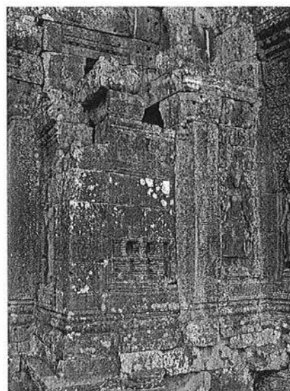
Ph. 198 : Blocage (en rouge) de la loggia Nord-Est de la tour BY.15
