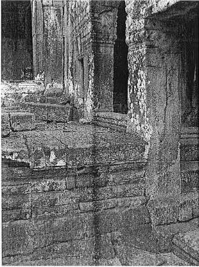
Ph. 217 : Connexion entre la terrasse se développant à l'Est de BY.39 et la galerie BY.23-24
