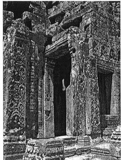
Ph. 201 : Avant-corps Nord (en rouge) de la tour BY.12
