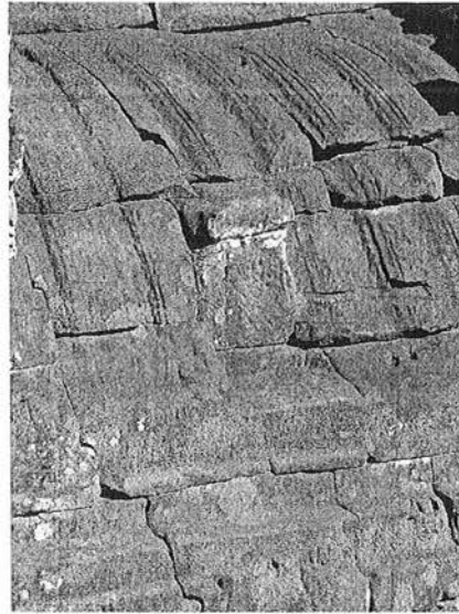
Ph. 165 : Détail de l'amorce du faitage de porche intérieure de la galerie BY.22-23
