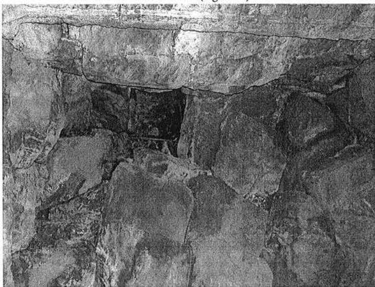
Ph. 171 : Extrados de la première voûte de BY.11
