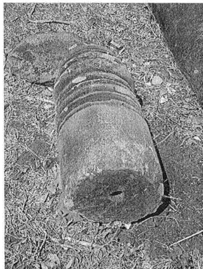
Ph. 21 : Exemple d'extrémité de balustre avec mortaise
