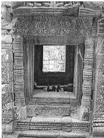
Ph. 20 : Exemple de fenêtre avec linteau décoratif et colonnettes
