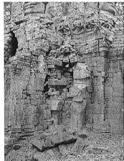
Ph. 96 : Motif d'angle Nord-Est de la porte Ouest d'Angkor Thom
