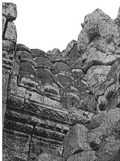
Ph. 190 : Connexion entre l'avant-corps Est de BY.13 et BY.14 (en rouge)
