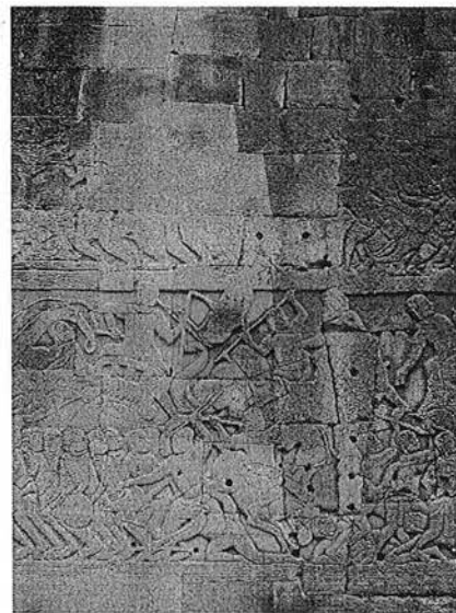
Ph. 15 : Exemple d'assises avec coins de forçage (en rouge) au mur de la galerie BY.64
