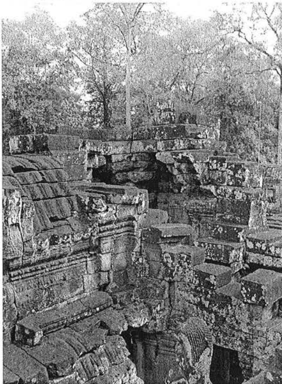
Ph. 79 : Vestiges de la tour BY.23
