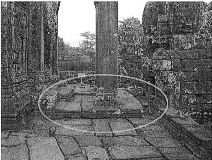
Ph. 142 : Porche oriental de la tour BY.15 recouvrant l'escalier axial Est du soubassement du troisième étage
