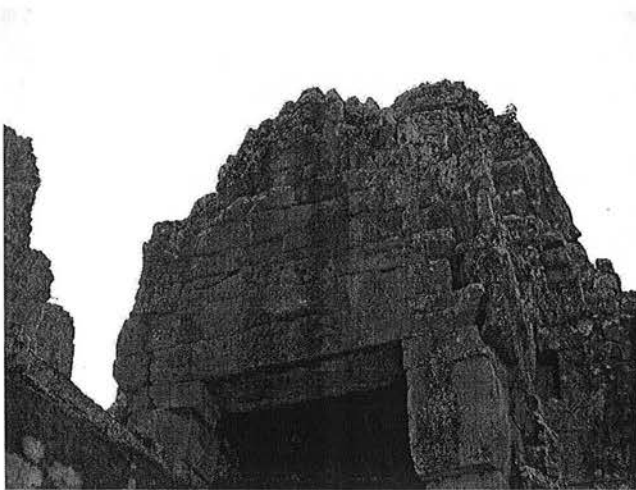
Ph. 175 : Fronton du porche Nord de la tour BY.31 du Bayon
