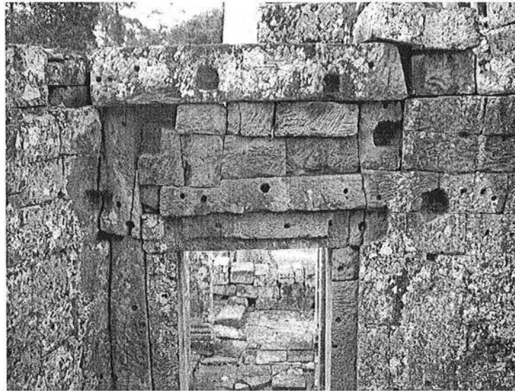
Ph. 243 : Logement de la charpente du porche devant la porte Nord de la galerie BY.70
