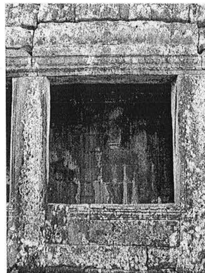
Ph. 215 : Adjonction d'allège à la galerie inférieure BY.47-37
