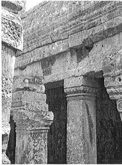
Ph. 159 : Galerie du palier supérieur du 2 ème étage avec bas-côté ruiné
