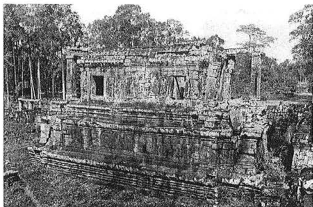
Ph. 40 : "Bibliothèque" Nord avant restauration en 1993 (JSA)
