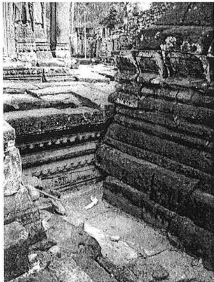
Ph. 244 : Connexion entre le soubassement de la “bibliothèque” BY.53 et le soubassement de BY.24
