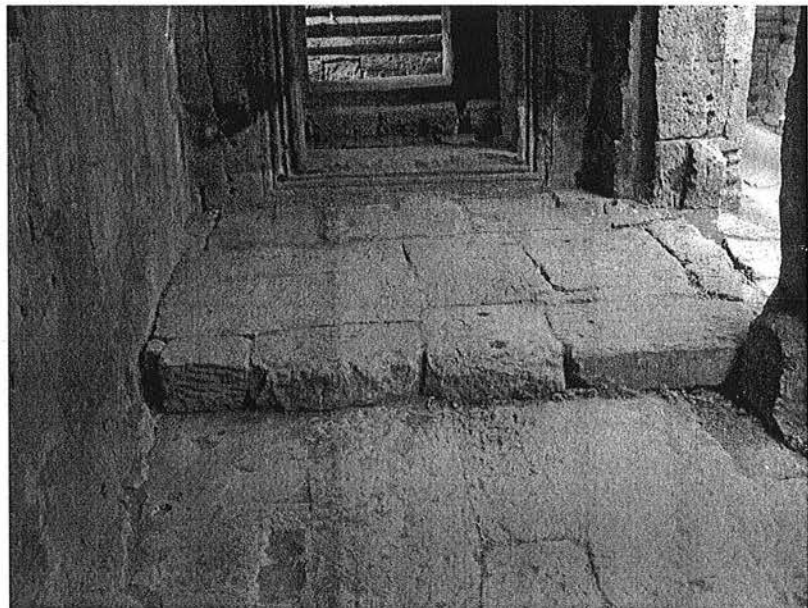
Ph. 134 : Surélévation du seuil oriental de la tour BY.40
