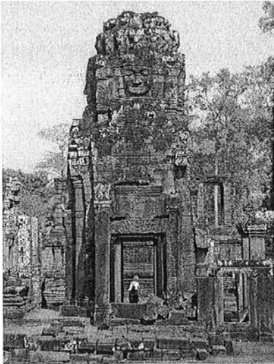
Ph. 232 : Face Sud de la tour BY.52
