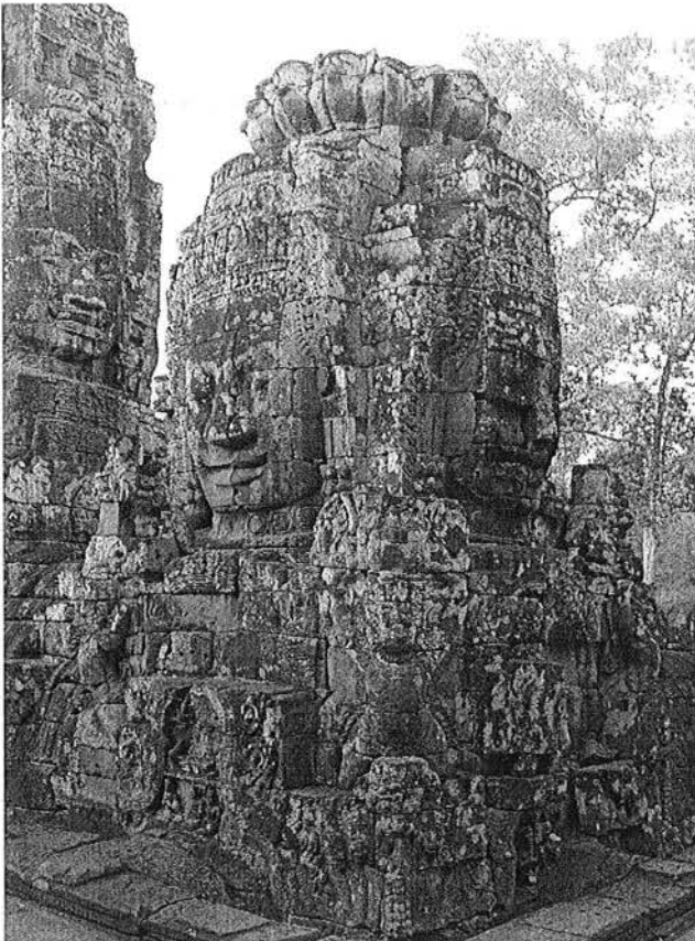
Ph. 82 : Exemple de tour à visages du deuxième étage avec garuda d'angle (Tour BY.49 84 )
