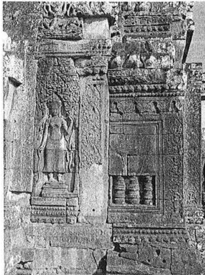
Ph. 197 : Blocage (en rouge) de la loggia Sud-Est de la tour BY.15
