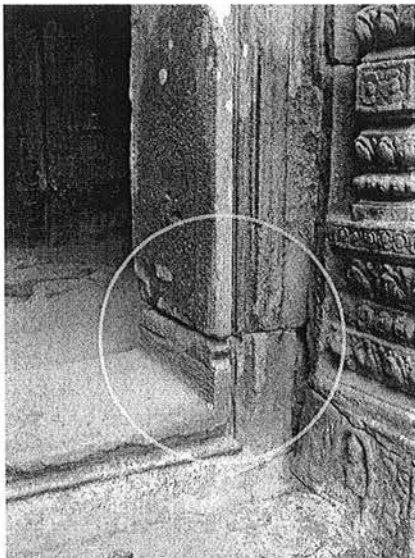
Ph. 199 : Seuil de la porte intérieure Nord de la tour BY.12
