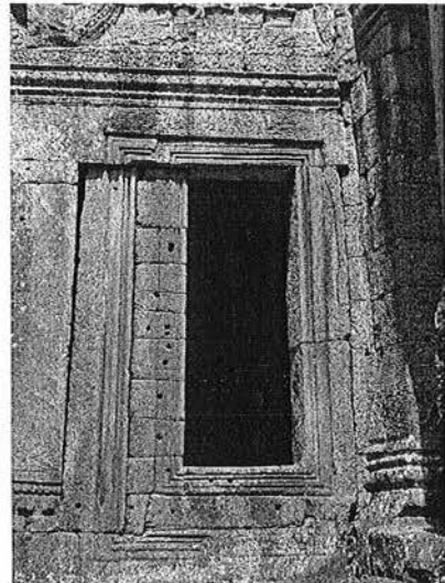
Ph. 220 : Porte Sud de la loggia Sud-Ouest de la tour BY.39
