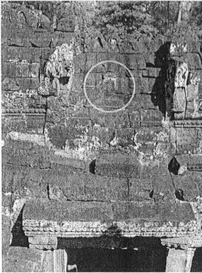
Ph. 164 : Porche intérieur de la galerie BY.22-23
