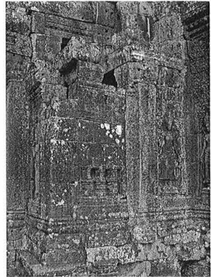
Ph. 198 : Blocage (en rouge) de la loggia Nord-Est de la tour BY.15
