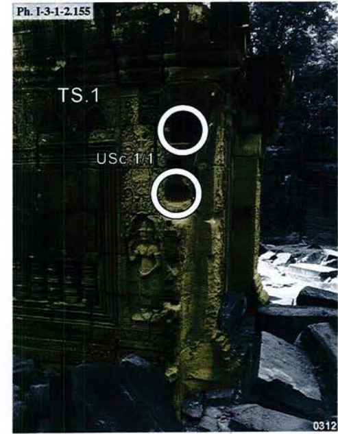
Ta Som, avant-corps Est du sanctuaire central TS.1 : USc 1/1
