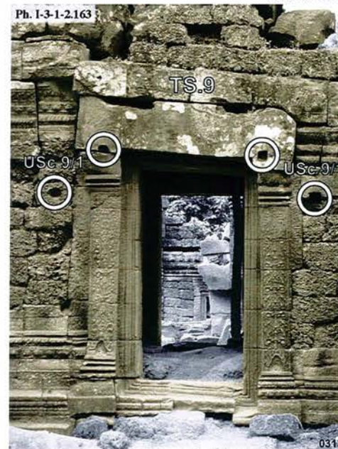
Ta Som, entrée Sud de la galerie Sud de la première enceinte TS.9 : USc 9/1
