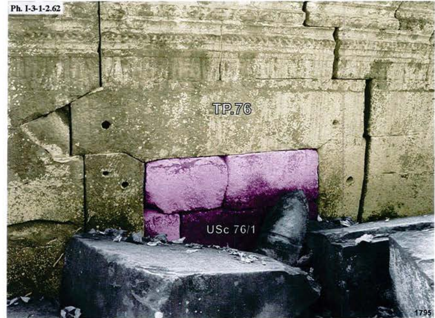
Ta Prohm, fenêtre murée de la galerie Sud TP.76 du cloître Nord : USc 76/1
