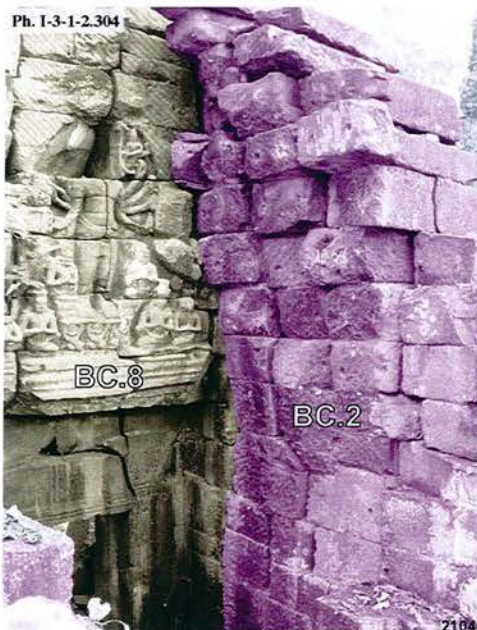
Banteay Chmar, fronton Ouest de la tour BC.2 et avant-corps Ouest BC.8 de cette même tour, mur intérieur Sud
