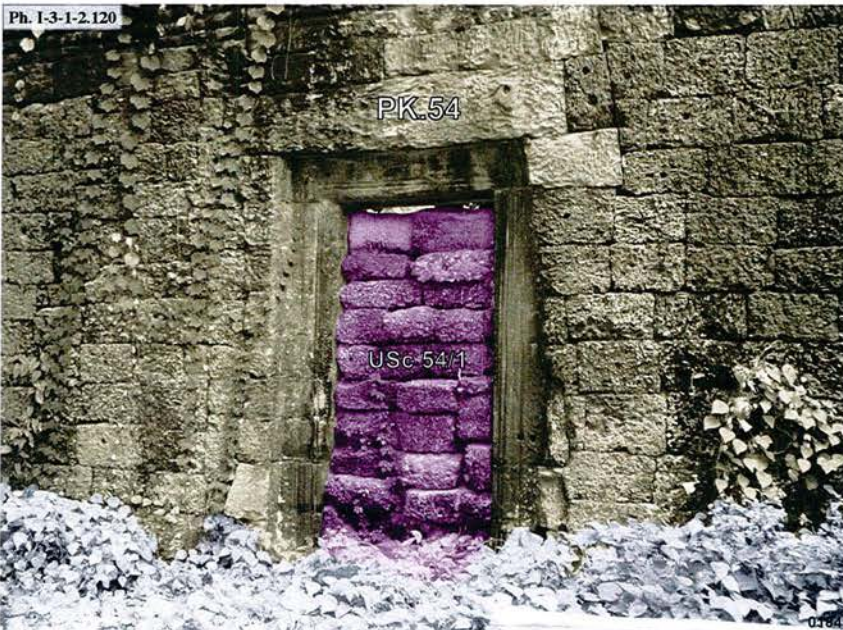
Preah Khan, porte Nord-Ouest de la galerie Ouest de la seconde galerie-enceinte PK.54, face Ouest : USc 54/1
