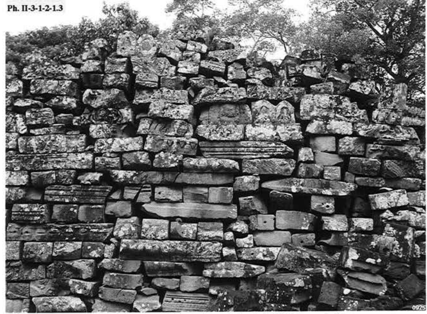
Bayon : tas "Commaille" contre le mur de la galerie BY.64 du premier étage
