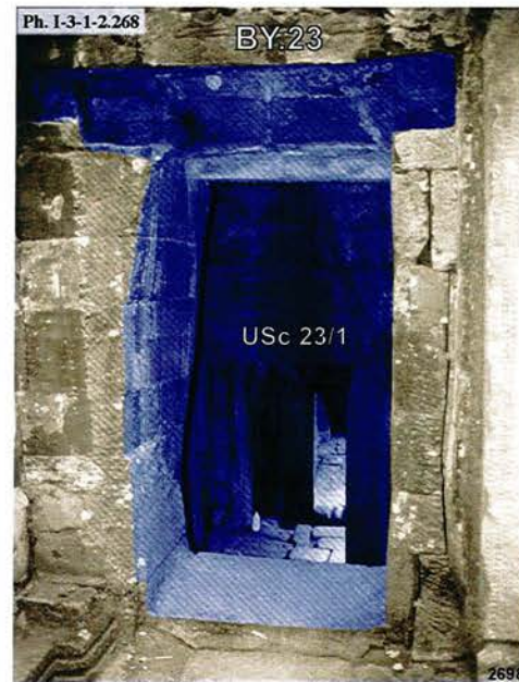
Bayon, porte Sud de l'avant-corps Ouest de la tour BY.23 de l'enceinte intérieure : USc 23/1
