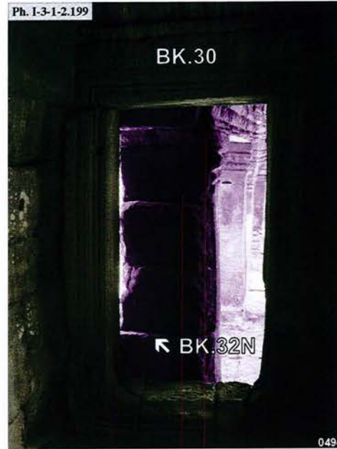
Banteay Kdei, loggia Nord-Ouest du pavillon Est BK.30 de la deuxième enceinte, connexion avec le bas-côté de la galerie BK.32N
