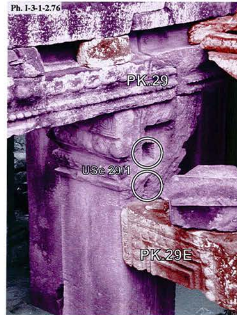
Preah Khan, connexion entre la galerie axiale Nord PK.29 avec son bas-côté Est 29E
