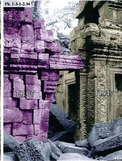
Ta Prohm, connexion entre le cloître Est TP.37 et le bras Ouest de la tour TP.47, face Sud
