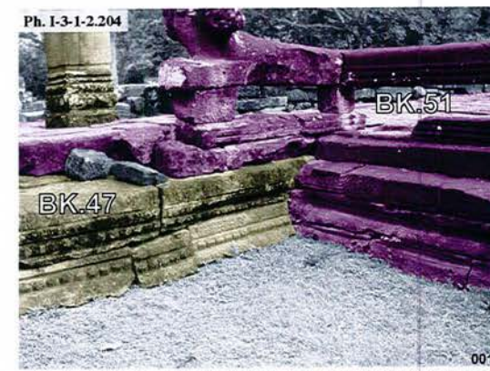
Banteay Kdei, connexion entre le soubassement du pavillon d'entrée Est BK.47 de la troisième enceinte et la terrasse cruciforme BK.51
