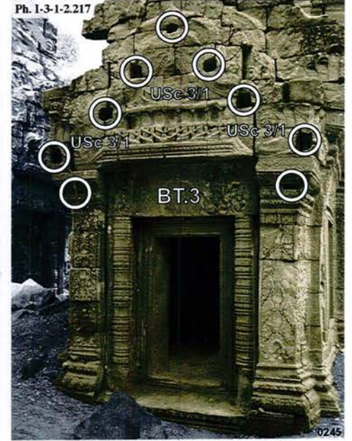
Banteay Thom, avant-corps Est du sanctuaire secondaire BT.3 face Est : USc 3/1
