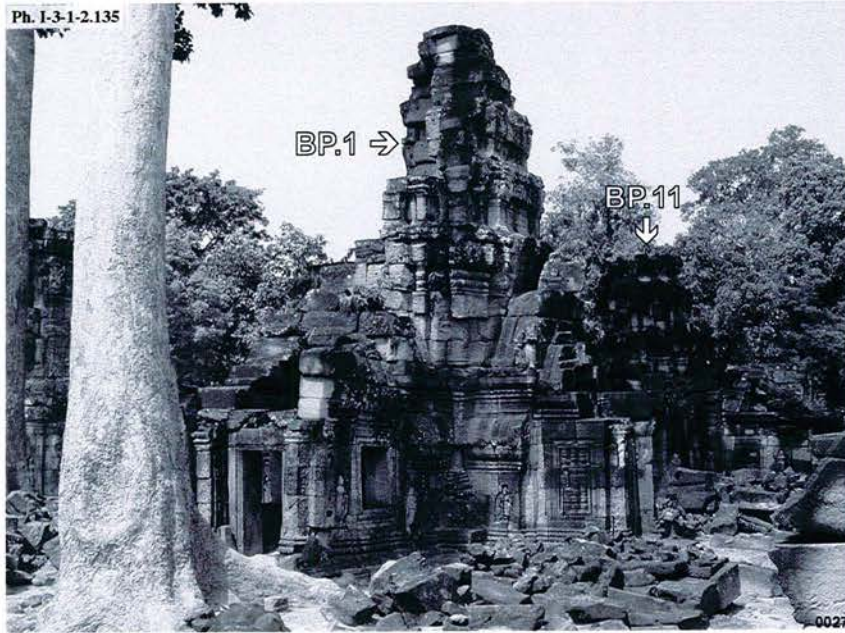
Banteay Prei, sanctuaire central BP.1 angle Nord-Est
