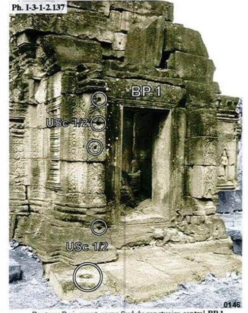
Banteay Prei, avant-corps Sud du sanctuaire central BP.1 face Sud : USc 1/2
