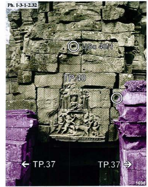
Ta Prohm, connexion entre l'avant-corps Est de la tour TP.40 et le cloître Est, face Est : USc 40/1
