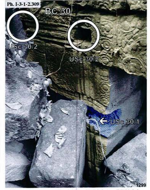
Banteay Chmar, porte Ouest du bras Sud de la tour BC.30 de la première enceinte : USc 30/1 et USc 30/2
