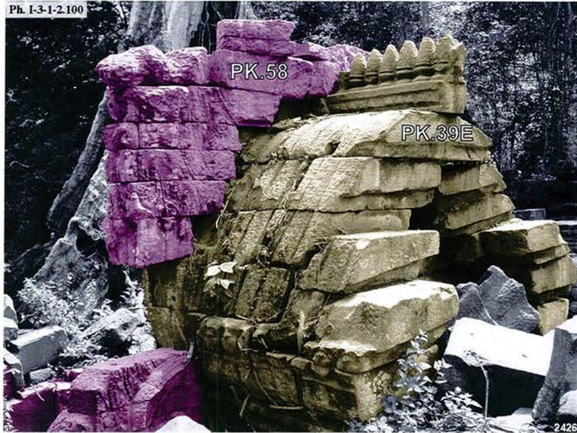
Preah Khan, connexion entre l'avant-corps Est PK.39E de la tour d'angle Sud-Est PK.39 de la première enceinte et l'édifice PK.58 de la seconde enceinte, face Ouest
