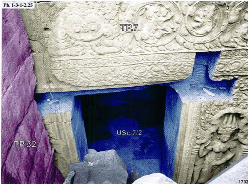
Ta Prohm, connexion entre la salle de passage TP.32 et l'avant-corps Sud de la tour axiale Est TP.7 de la première enceinte : USc 7/2
