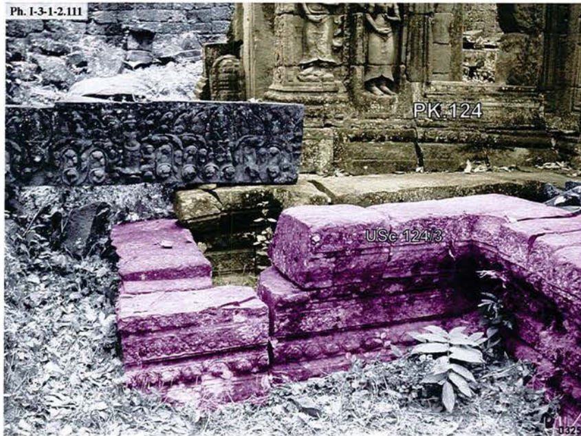
Preah Khan, soubassement Nord-Est de la tour axiale Est PK.124 de l'enceinte du complexe Nord : USc 124/3
