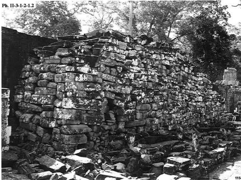
Bayon : tas "Commaille" contre le mur de la galerie BY.56 du premier étage
