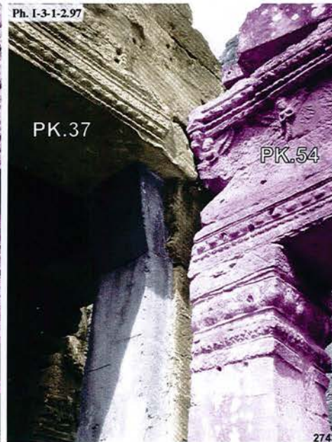
Preah Khan, connexion entre le porche de l'avant-corps Est du pavillon PK.37 de la première enceinte et la galerie du seconde enceinte
