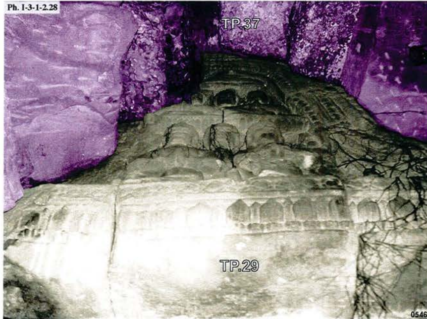
Ta Prohm, connexion entre l'extrémité Nord du fronton commun aux salles de passage TP.30 et TP.29 et le cloître Est TP.37
