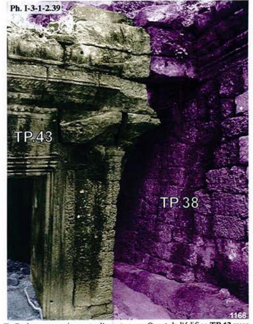
Ta Prohm, connexion entre l'avant-corps Ouest de l'édifice TP.43 avec la seconde galerie-enceinte, vue Nord
