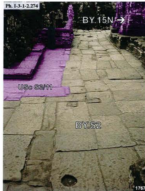
Bayon, dallage Nord-Est de la terrasse du troisième étage S3/11
