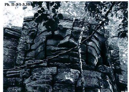
Banteay Chmar : face Nord du sanctuaire central BC.III-1 du temple-satellite III
