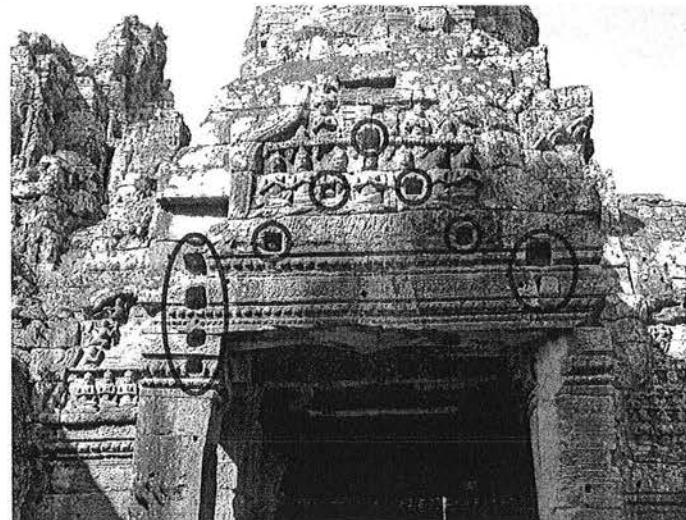
Ph. 126 : Empreintes de la charpente de l'appentis en bois greffé au porche de l'avant-corps oriental de la tour BY.48
