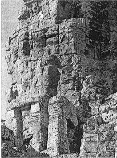
Ph. 71 : Face Nord de la tour BY.1
