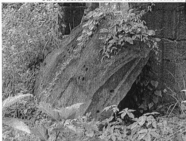
Ph. 85 : Pierre constituant originellement l'extrados de la croisée de voûte du pavillon d'angle Sud-Est PK.101 de l'enceinte du complexe occidental du Preah Khan d'Angkor
