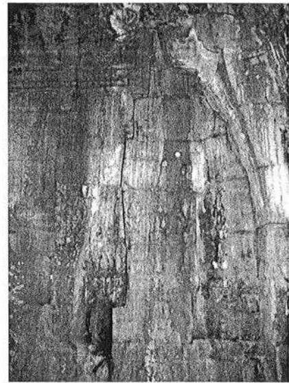
Ph. 151 : Exemple intérieur de raccord entre une tour du deuxième étage et sa galerie
