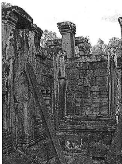
Ph. 240 : Bouchages de fenêtres de BY.63 côté cour du premier étage
