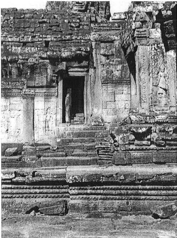
Ph. 177 : Connexion entre la galerie BY.23-24 (en rouge) et l'avant-corps Sud de la tour BY.23 (vue de la cour du 1 er étage)
