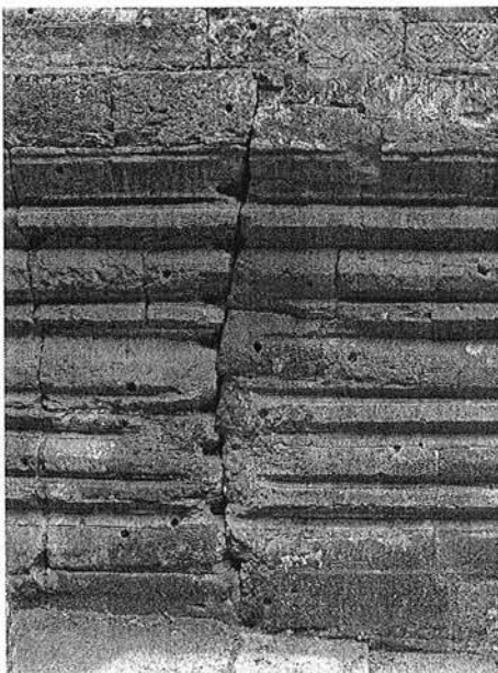
Ph. 205 : Blocage Ouest (en rouge) du bras Nord du soubassement du troisième étage
