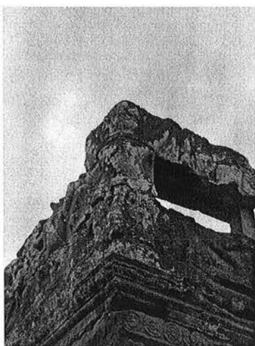
Ph. 68 : Exemple de garuda d'angle intérieur du pavillon BY.67
