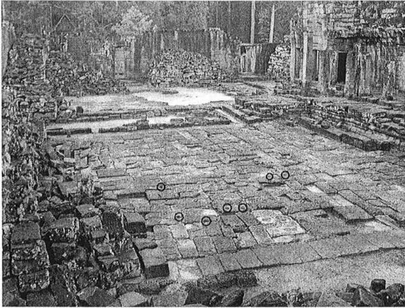
Ph. 127 : Dallage de la cour du premier étage entre les vestiges des salles-passages BY(E) et BY(F)
