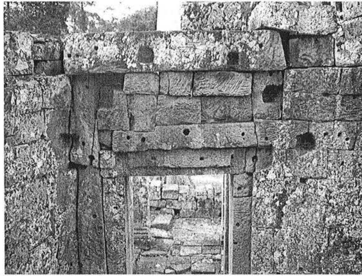
Ph. 243 : Logement de la charpente du porche devant la porte Nord de la galerie BY.70
