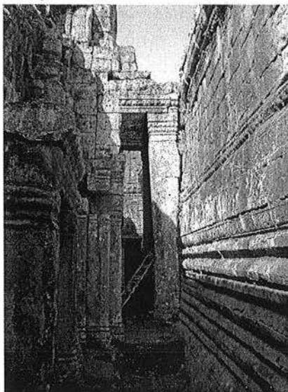
Ph. 161 : Jonction entre le porche Nord de la tour BY.26 et le bras Sud du soubassement du troisième étage
