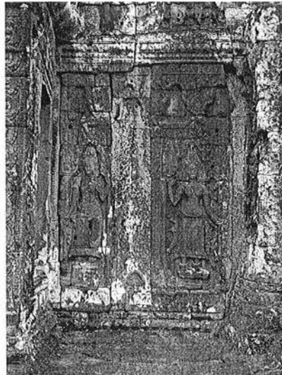
Ph. 228 : Bouchages des accès extérieurs Sud entre BY.14 et BY.15
