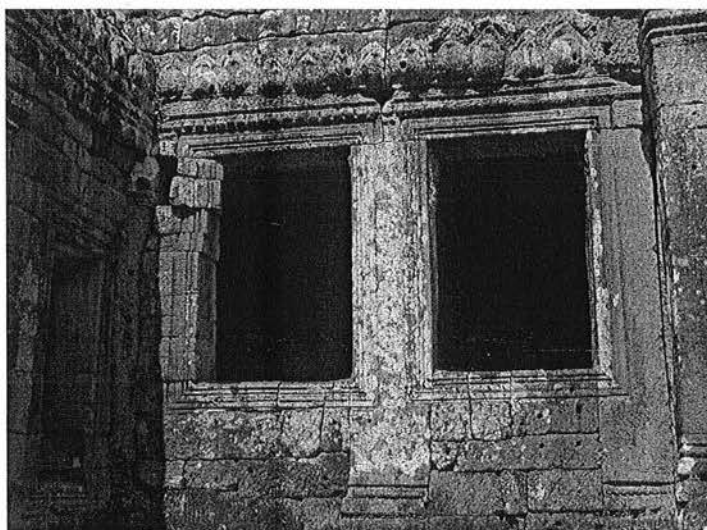
Ph. 219 : Bas-côtés extérieur des galeries BY.40-25 (à gauche) et BY.39-40 (à droite)
