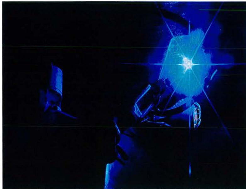
Figure 1.5 : Opération robotisée de soudage sur le fond de la cuve réacteur
