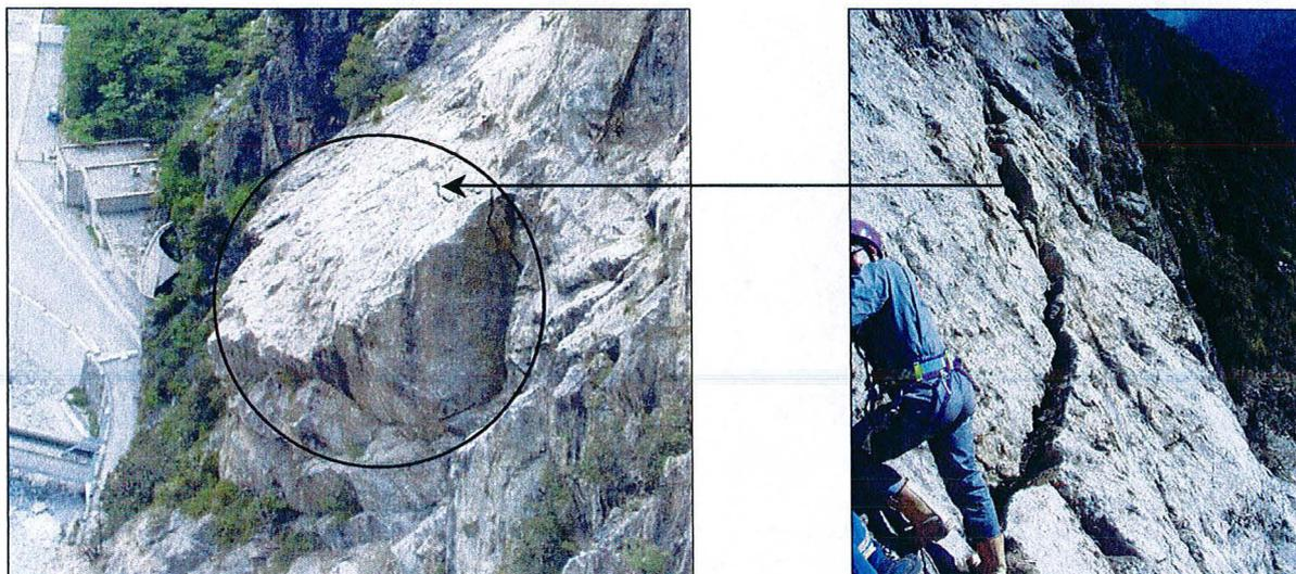
Figure 2-8 : Situation préoccupante d'un bloc rocheux avant dynamitage.
