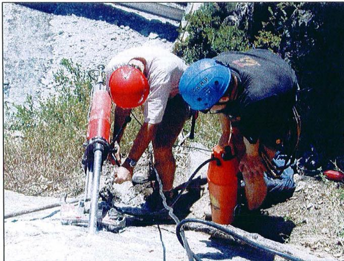
Figure 4-22 : Réalisation d'un forage destiné à recevoir une sonde microsismique.
