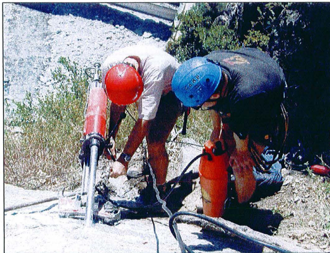
Figure 4-22 : Réalisation d'un forage destiné à recevoir une sonde microsismique.
