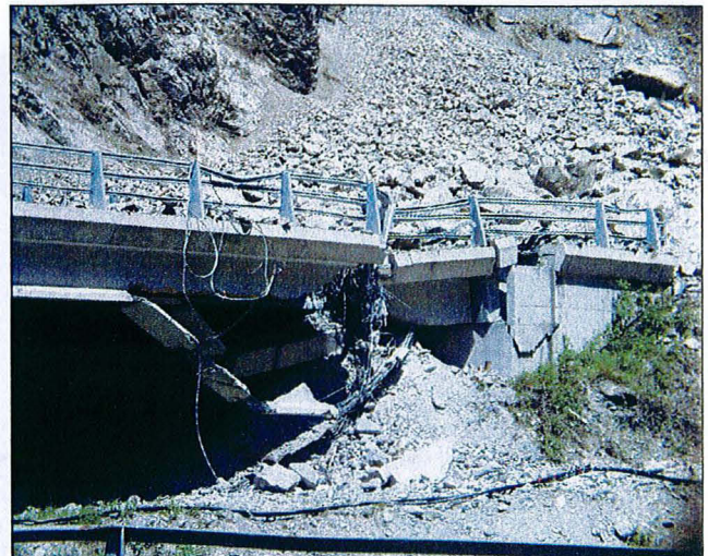
Figure 2-7 : Dégâts occasionnés par l'éboulement du 13 mai 2000.
